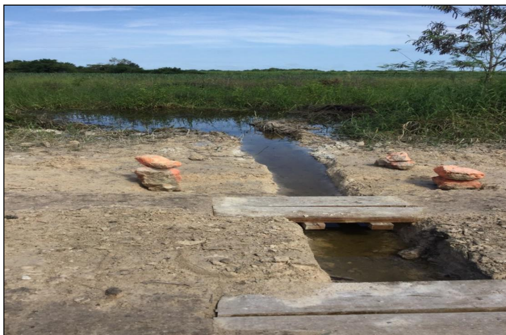
Figura 16: Tipo de drenaje realizado a mano por productores pequeños de caña en el distrito de Corozal. Fuente: Propia, 2017
