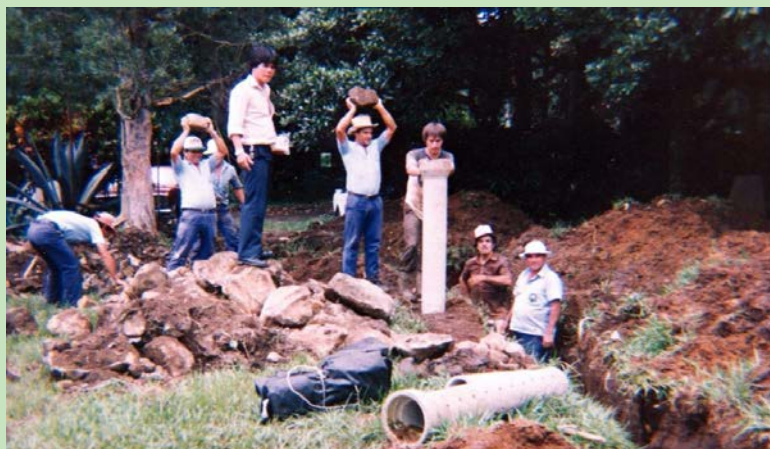
Foto 33. Elaboración de un drenaje.
