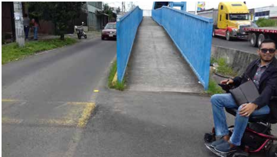
Figura 3. Puente peatonal. Fuente: Paniagua (2022).
