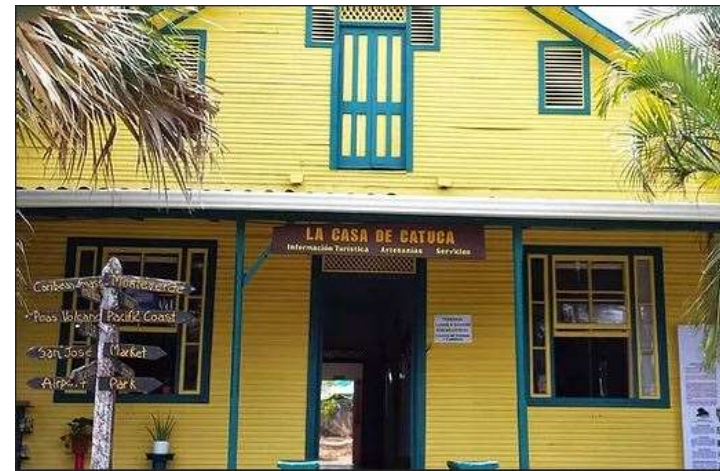
IMAGEN 33 Fachada de Casa CATUCA Fuente: Cluster Atenas (2019)
