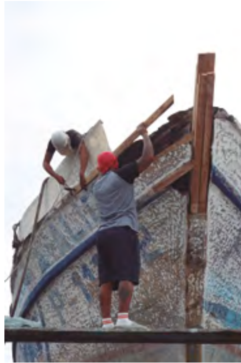
Kevin Ariel Rodríguez González y Jean Carlos Maroto Rodríguez. Proceso de restauración de la parte superior frontal de la embarcación para luego ser enfibrada. Embarcación Cornuda Azul .
