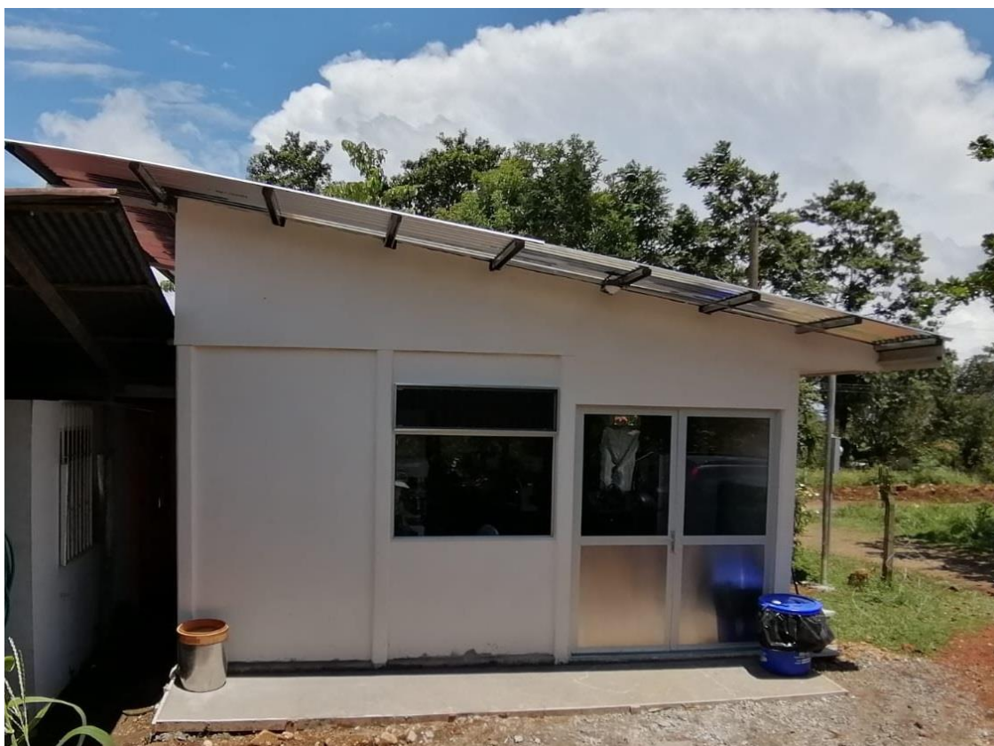
Figura 2. Planta Condimentos Solís, Aguas Zarcas, San Carlos.
