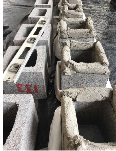
Figura 26. Colocación de mortero en prismas
