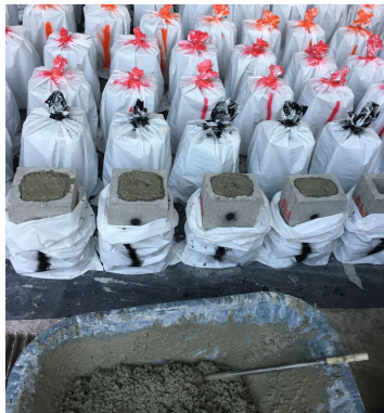
Figura 34. Colocación de concreto de relleno
