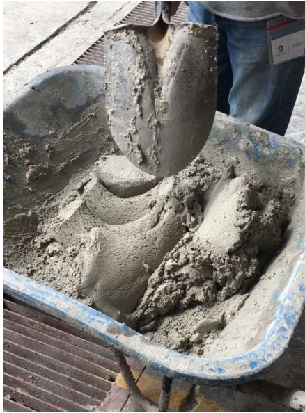
Figura 25. Preparación del mortero
