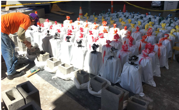
Figura 32. Colocación de mortero de pega
