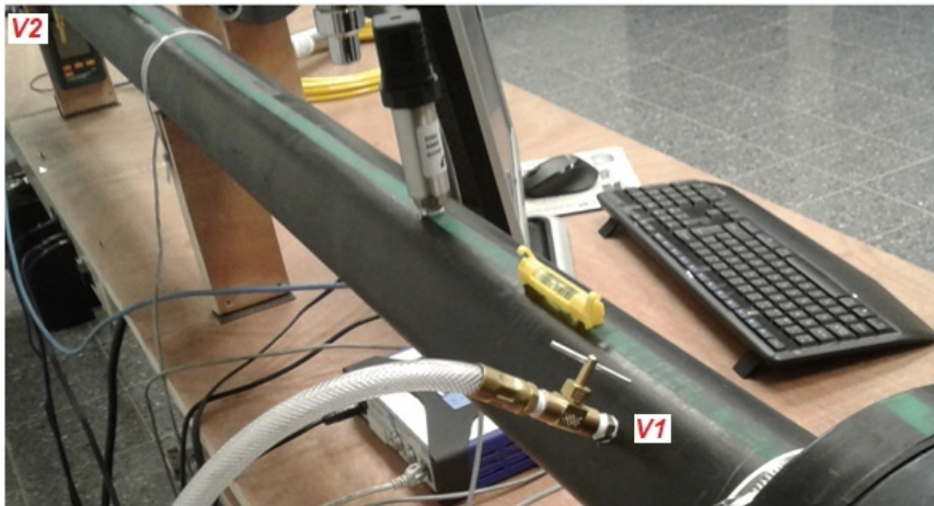
Figura 32. TC-02-(0.6/2). Sistema de secado del aire en la cámara de expansión.
