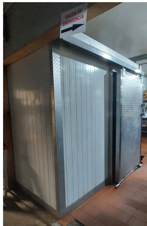
(f) Cuarto de frío.
