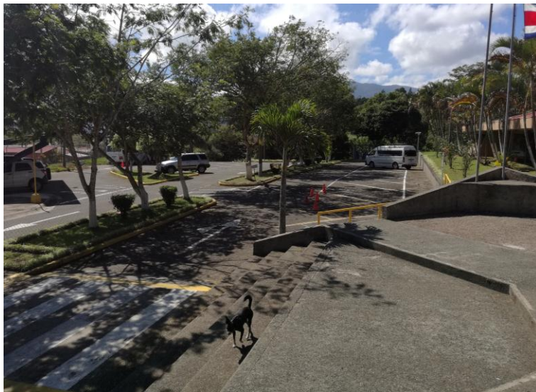
91. VISUAL 3 / PEQUEÑA PLAZA DE ACCESO AL EDIFICIO PRINCIPAL Y ZONA DE PARQUEOS
