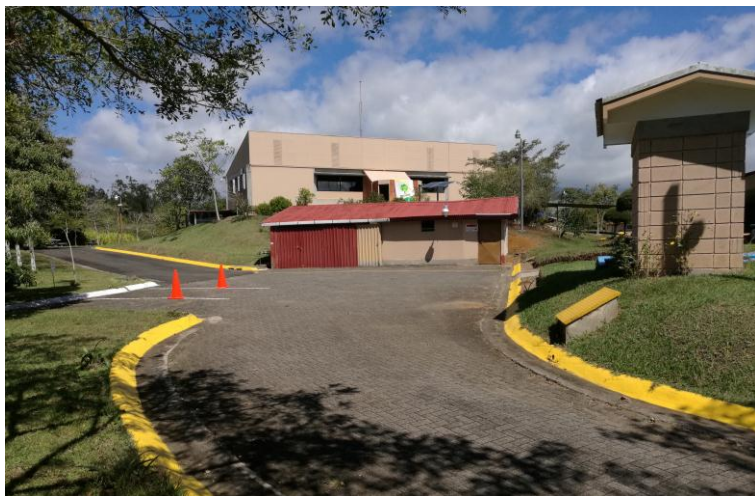
14. Recinto universitario, cuarto de máquinas y bodega, fuente propia, junio 2018.
