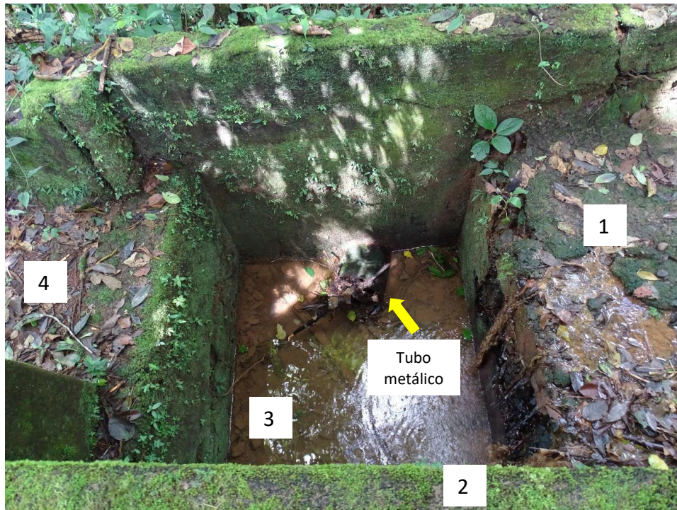
Figura 38. Vista superior del tanque de agua y división de aguas
