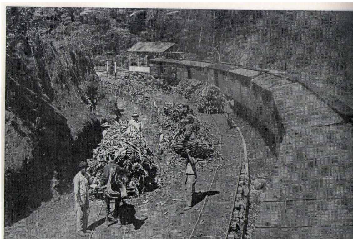
Figura 7. Burrocarril en funcionamiento, contiguo a la línea férrea en Pejibaye
