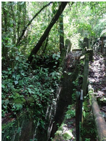
A: Vista de la parte superior de la estructura de la turbina Pelton (vista de N a S).
