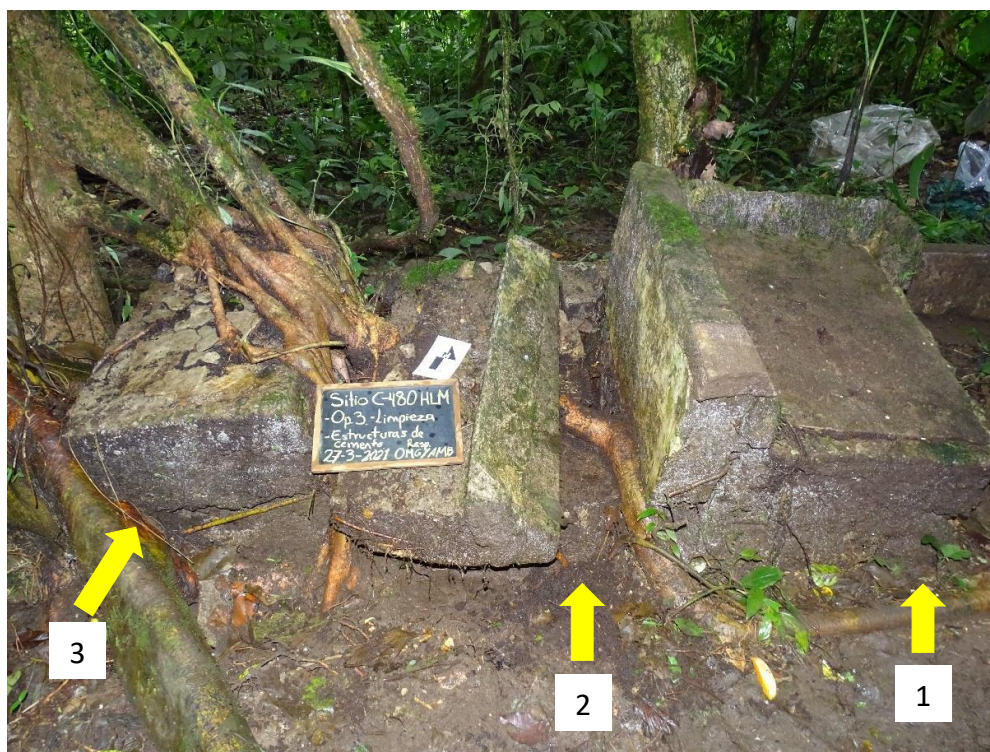
Figura 33. Bloques de cemento (pilas) que se ubican en la zona de la casa
