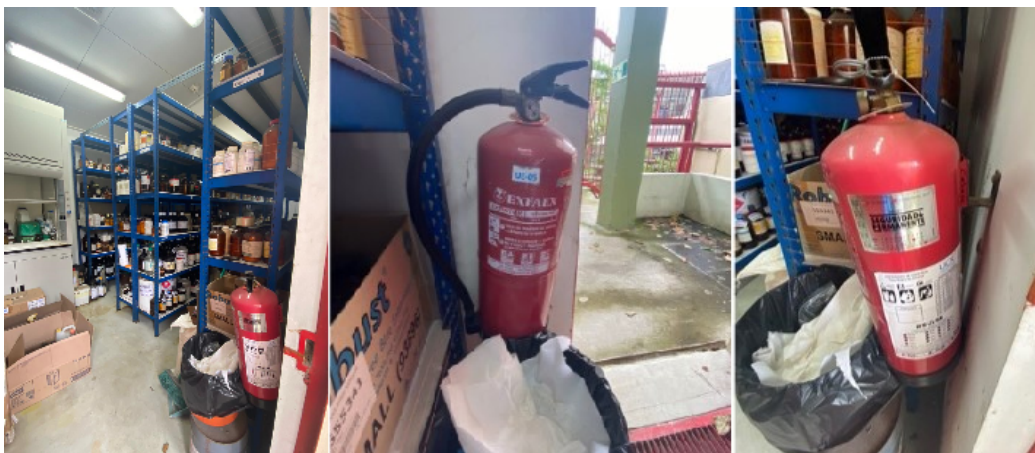
Imagen 6. Extintor de polvo químico presente en la bodega de almacenamiento de productos químicos del CELEQ.
