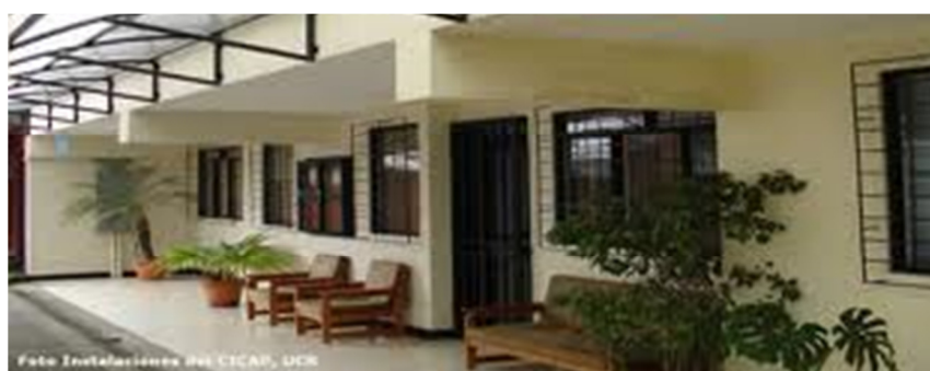
Figura N°4.1.2.1: Fotografía de las instalaciones administrativas del CICAP.
