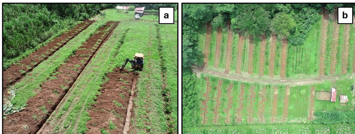
Figura 29. Construcción de la red de drenajes del ensayo. a) Vista frontal del trabajo de excavación para la construcción del sistema de drenajes del ensayo. b) Red final de drenajes construidos (2019)
