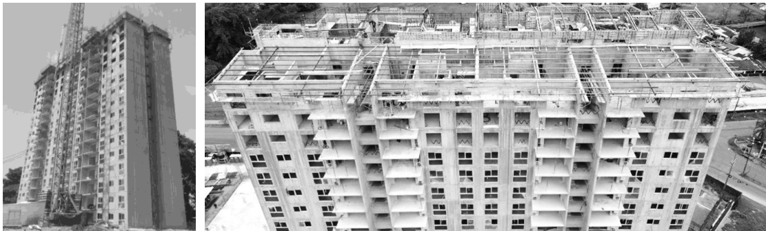
Figura 4. Construcción de edificio residencial con sistema tipo cajón. Fuente: El autor.
