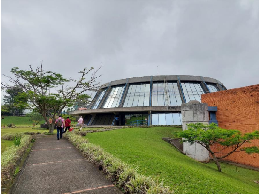
Figura 3. Actual edificio del Archivo Nacional, ubicado en Zapote-Curridabat, San José, Costa Rica.
