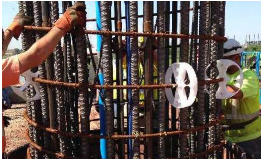
Figura 92: Separadores de plástico para armadura de pilotes. Tomado de (Federal Highway Administration, 2018)
