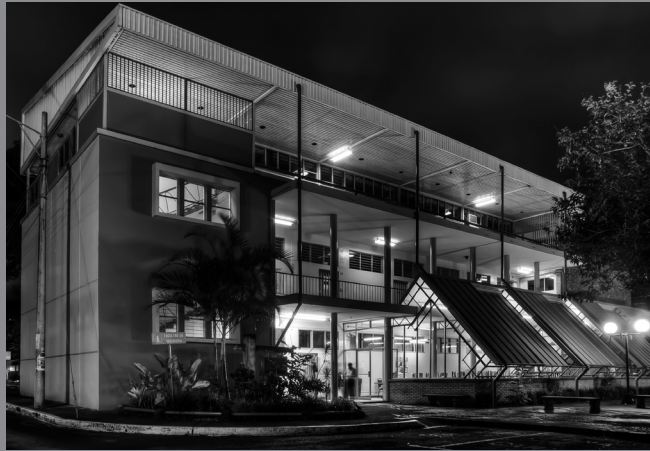
Foto 24: Construcción de la soda del edificio de la Facultad de Ingeniería. Agosto, 1998
