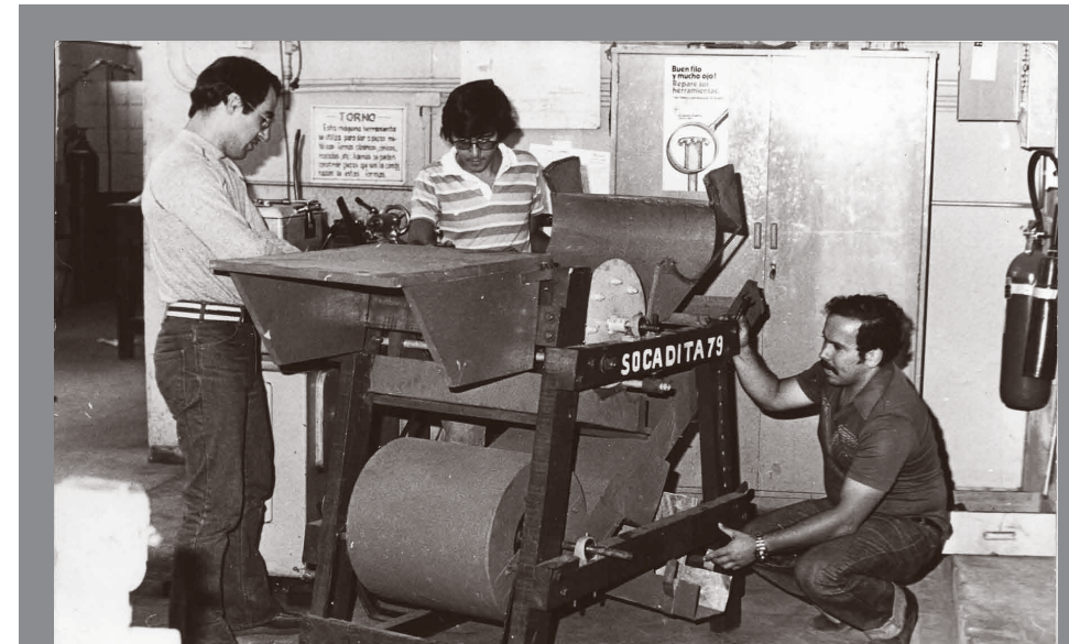
Foto 46: Máquina trilladora de frijol. Escuela de Ingeniería Mecánica. Marzo 1979. Archivo ODI
