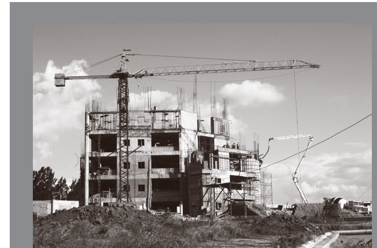
Foto 45: Edificio de Ingeniería Eléctrica en construcción. Marzo 2005. Archivo ODI
