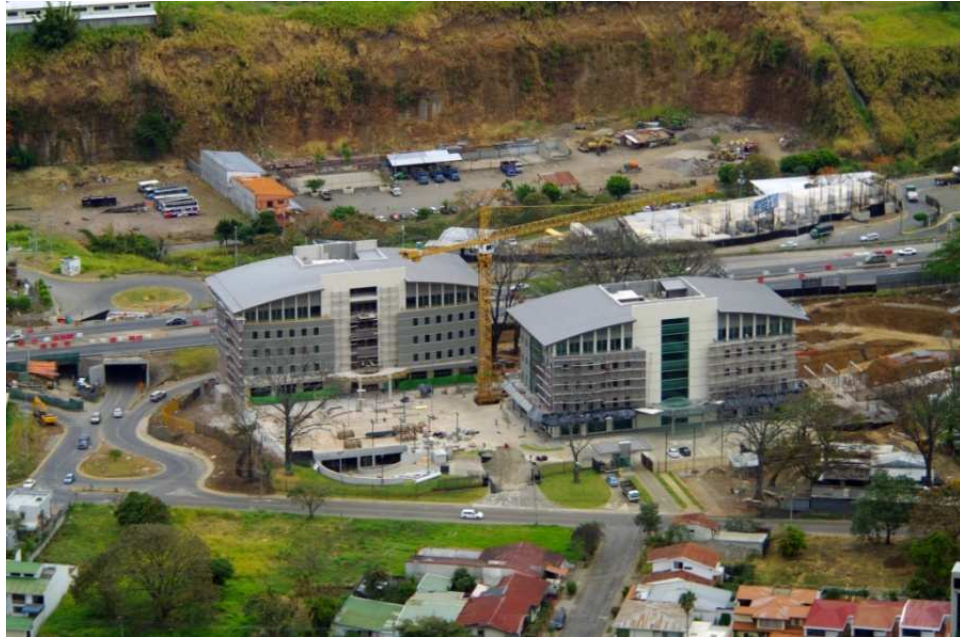
Imagen 3.1: Oficentro El Cedral Fuente: FSA Ingeniería & Arquitectura
