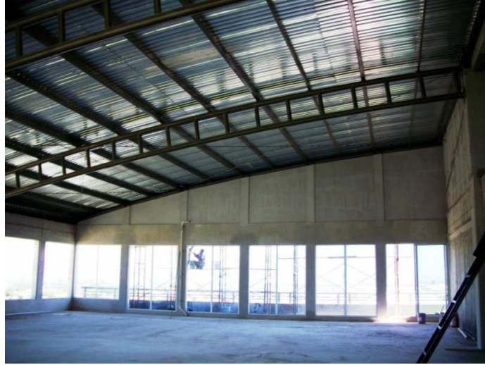
Imagen 3.4: Estructura de techo Nivel 5, Edificio 1
