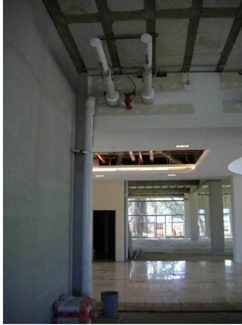
Imagen 3.8: Previstas de agua helada Nivel 1, Edificio 1
