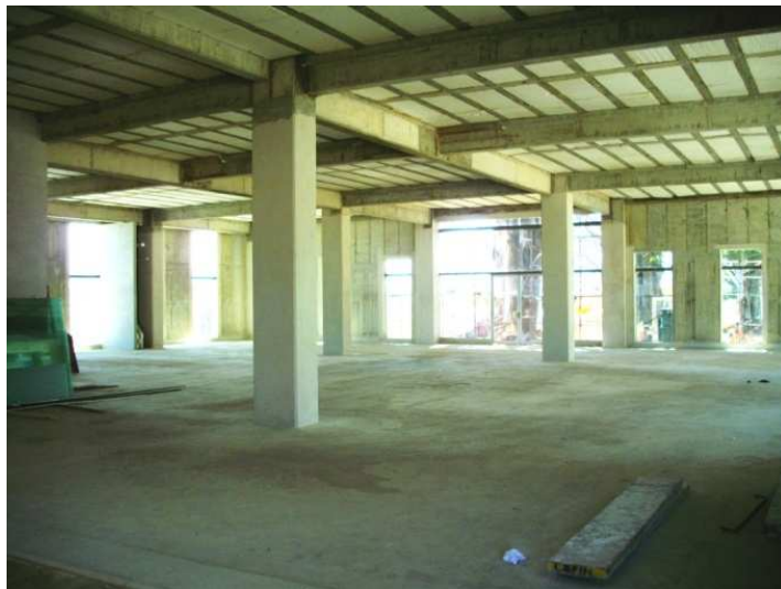
Imagen 3.3: Estructura principal Nivel 1, Edificio 1
