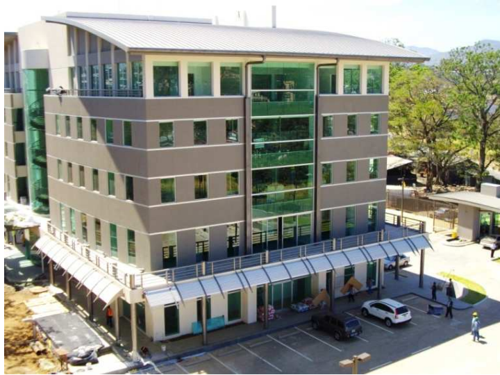
Imagen 3.2: Fachada Norte y Oeste Edificio 2
