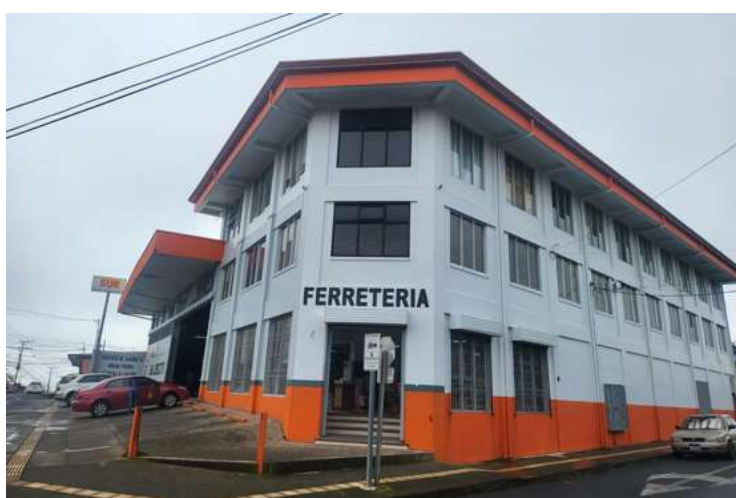
Figura 2. Edificio del Deposito y Ferreteria San Josecito.
