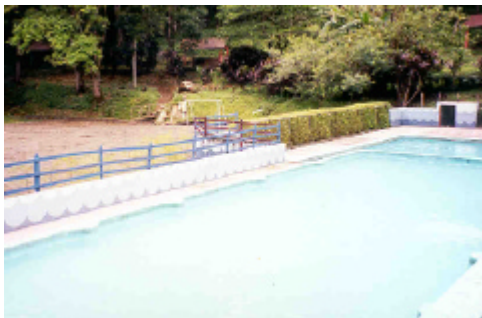
Fotografía 18. Piscinas del Parque del Este: los visitantes opinan que necesitan más mantenimiento.
