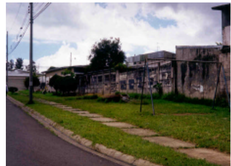
Fotografía 17. Mantenimiento deficiente en área verde de Urbanización
