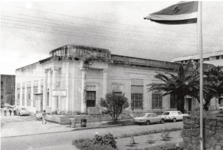
Fotografía 2.4: Edificio de la Universidad de Costa Rica en Barrio González Lahmann, 1941. Archivo Museo Calderón Guardia.
