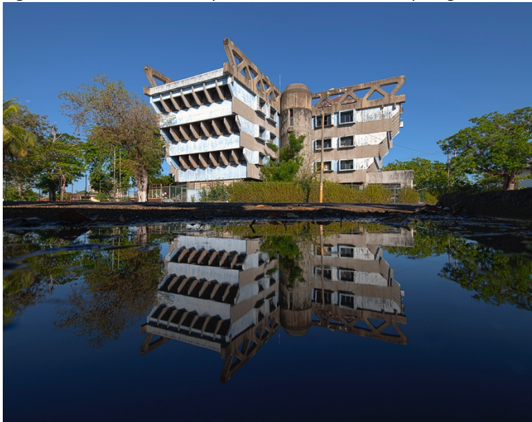
Fig. 34. Edificio de la Municipalidad de Puntarenas. Arq. Jorge Bertheau. 2022. Puntarenas.
