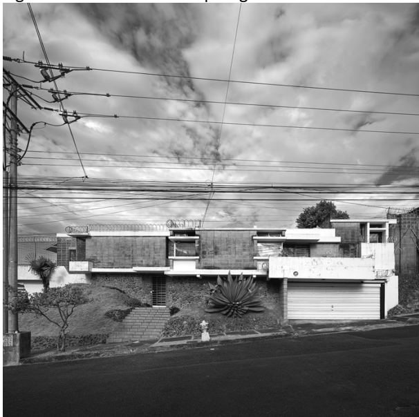
Fig. 7. Casa Berrocal M. Arq. Jorge Bertheau. 2023. San José.
