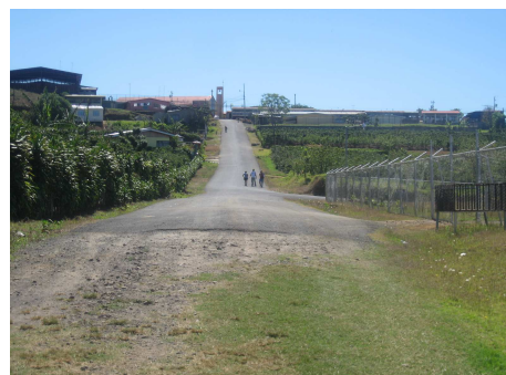
Fotografía 9-2.11. Carrizal. Obsérvese la falta de aceras.
