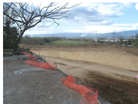
Fotografía 9-2.17 Construcción de la nueva carretera a Caldera
