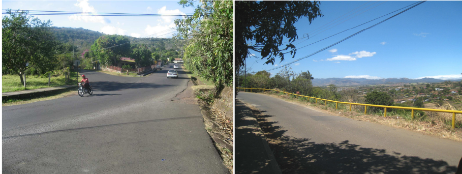
Fotografía 9-2.34. Infraestructura Vial de la zona de Quebradas
