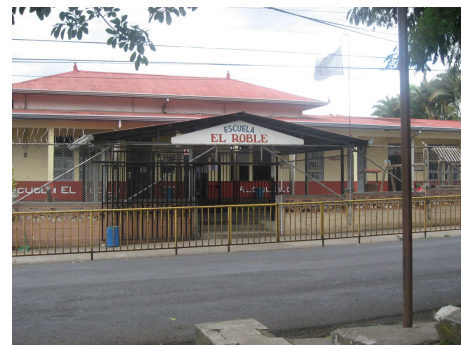
Fotografía 9-2.14. Escuela del Roble. Falta paso peatonal
