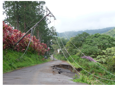
Fotografía 9-2.42. Carretera afectada por el terremoto en Cinchona.
