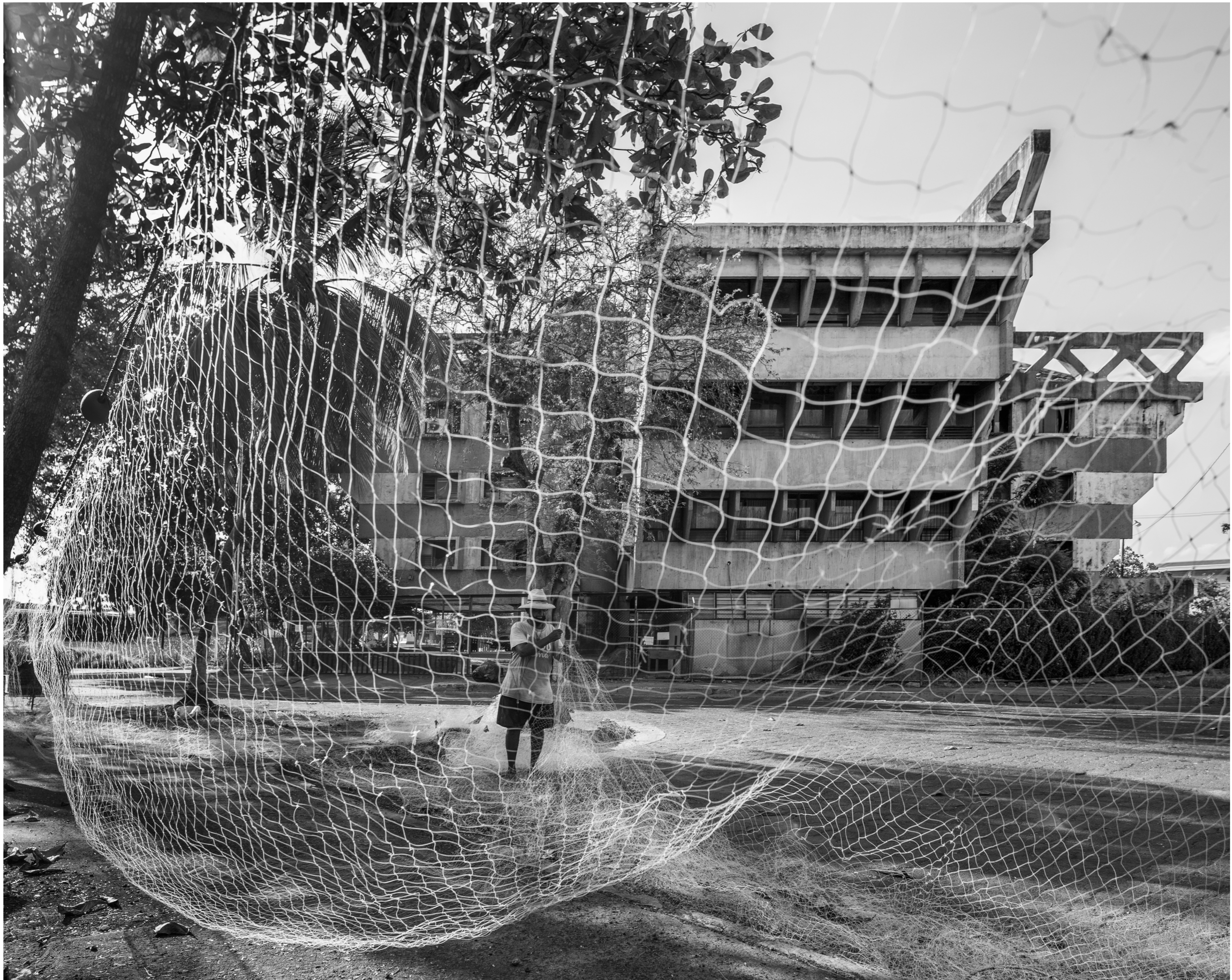
Antiguo edificio de la Municipalidad de Puntarenas. Arquitecto Jorge Bertheau. Fotografía Ricardo Chaves. Puntarenas, Costa Rica, 2022
