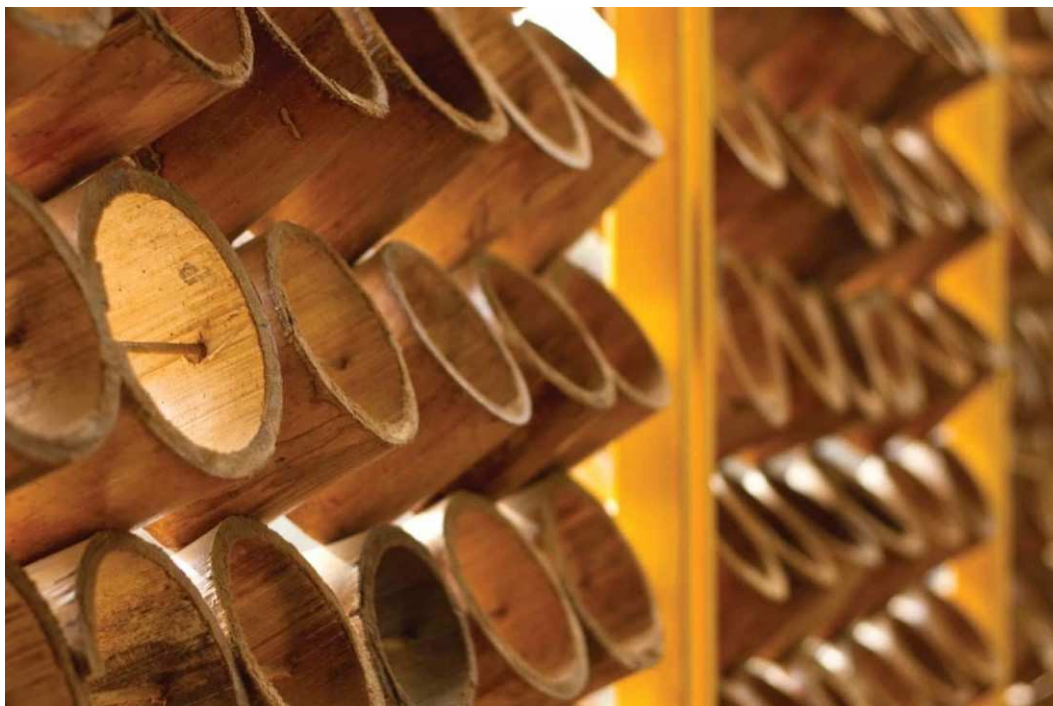
Imagen 10 - Detalle del cerramiento con piezas de bambú. Fuente: Imagen cortesía de Studio Saxe (2010).
