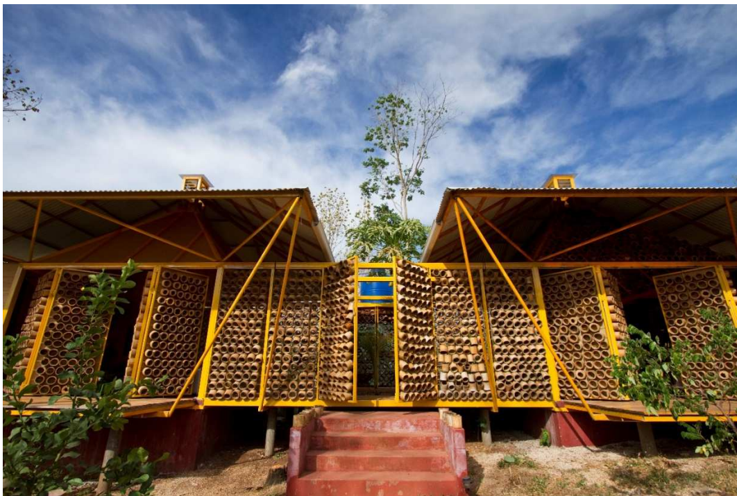
Imagen 7 - Fachada principal de la casa, donde se muestra la aplicación del bambú como parte de los paneles. Fuente: Imagen cortesía de Studio Saxe (2010).
