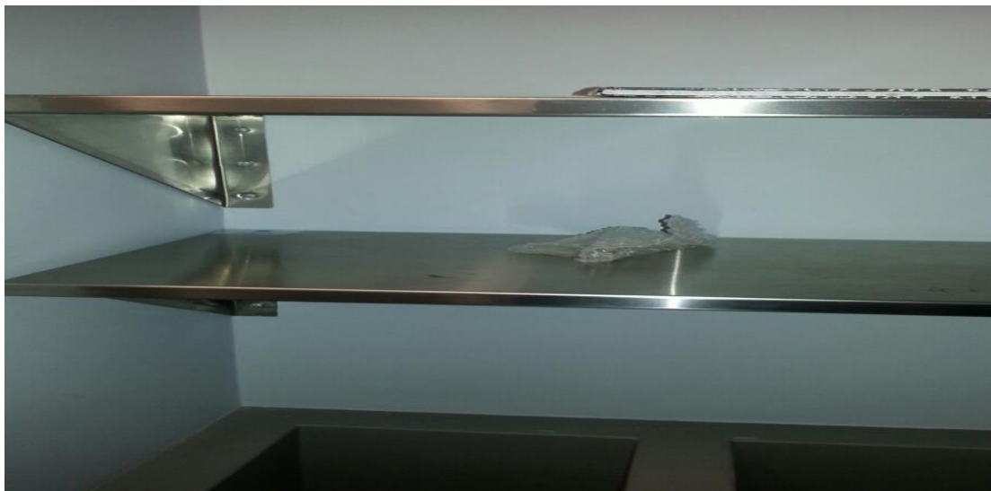
Figura # 7. Fuentes de cesio 137 y europio 152 que se encuentran en la bodega de decaimiento interno. Servicio de medicina nuclear, Hospital Clínica Bíblica.
