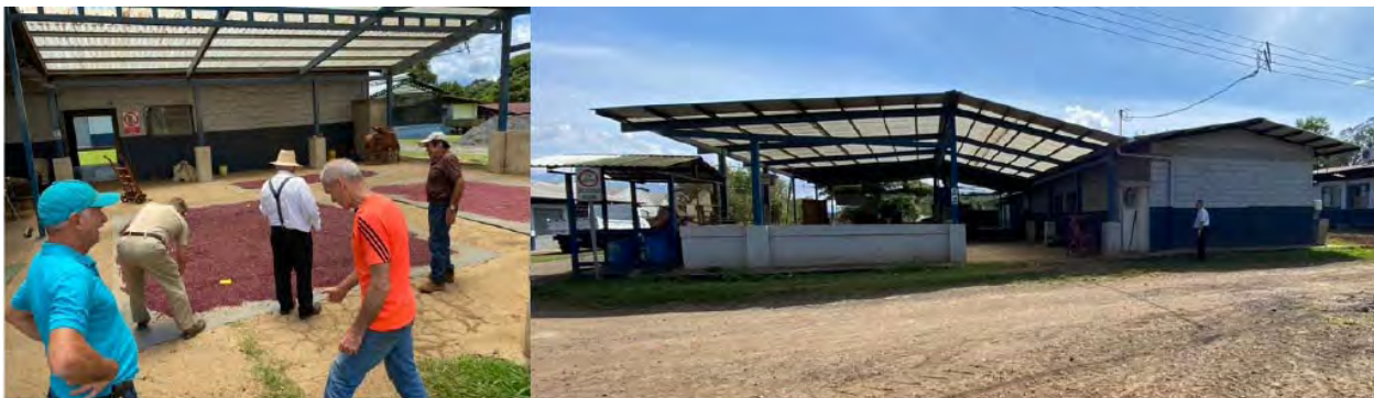
Primer patio de secado de granos de la EEAFBM. 2023.
