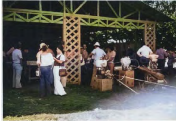
Galerón para el parqueo de vehículos, tractores e implementos agrícolas. Usado en 1976 para exposición durante la visita del presidente Daniel Oduber Q.
