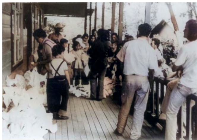
Corredor de las antiguas oficinas construido en 1958 (Fotografía Eladio Ramírez).
