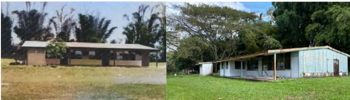
Aulas prefabricadas en el año 1979. A la izquierda foto de 1982, y a la derecha foto de 2022.
