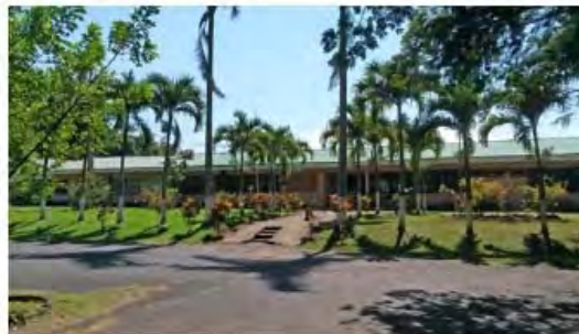
Entrada principal del nuevo edificio de oficinas
