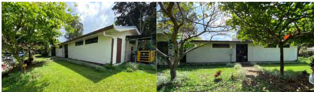
Edificio para conservación de semillas
