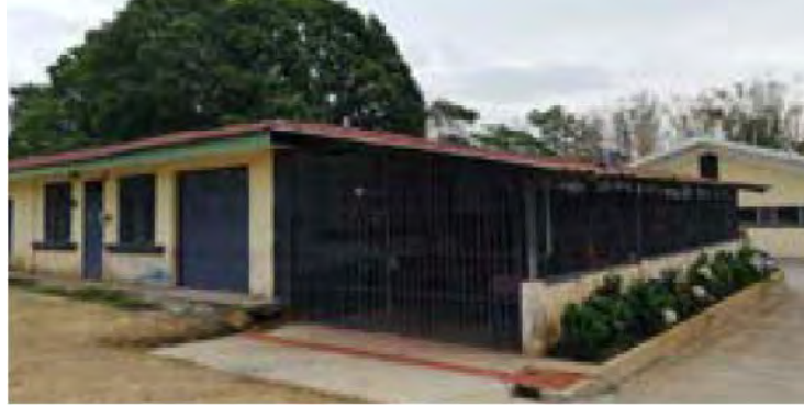
Taller de mantenimiento en 1994, luego de la tercera remodelación (Foto: Cerdas 2019).
