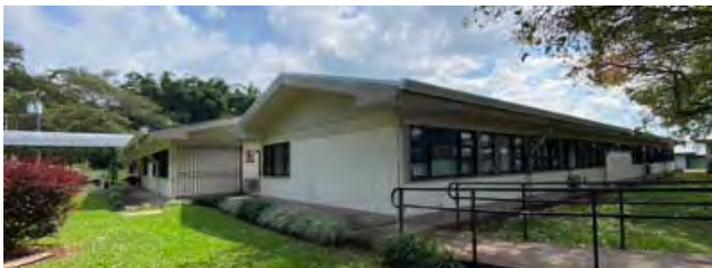
Sector oeste, primera etapa, área de oficinas.
