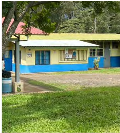
Actual bodega de materiales e insumos diversos.
