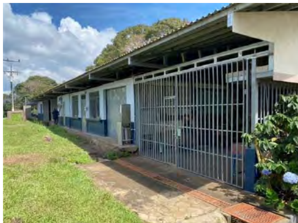
Última remodelación del área del Galerón efectuada en el año 2021 (costado sur) de carpintería, de tractores y vehículos. El área original de carpintería que estuvo bajo el manejo del señor Eladio Villalta.
