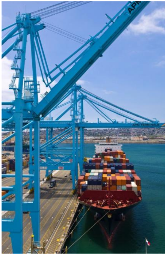
Figura 44. Grúa STS en Muelle 400 Los Angeles, EUA. Fuente: (APM Terminals S.A., 2013)
