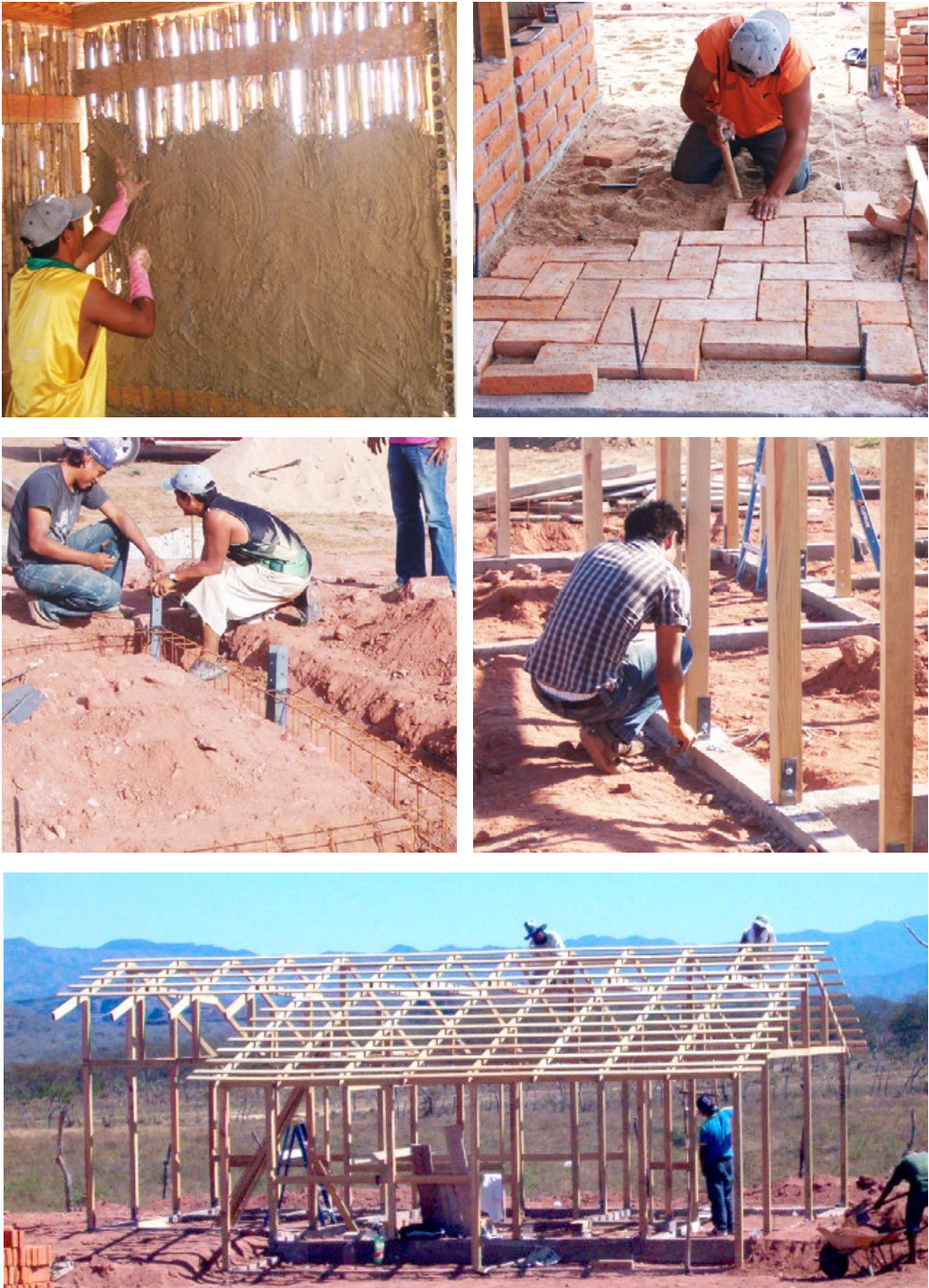
Desarrollo del proceso constructivo del bajareque mejorado
