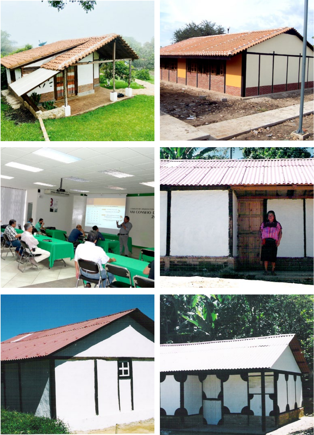
Diversas obras concluidas con el sistema de bajareque mejorado
