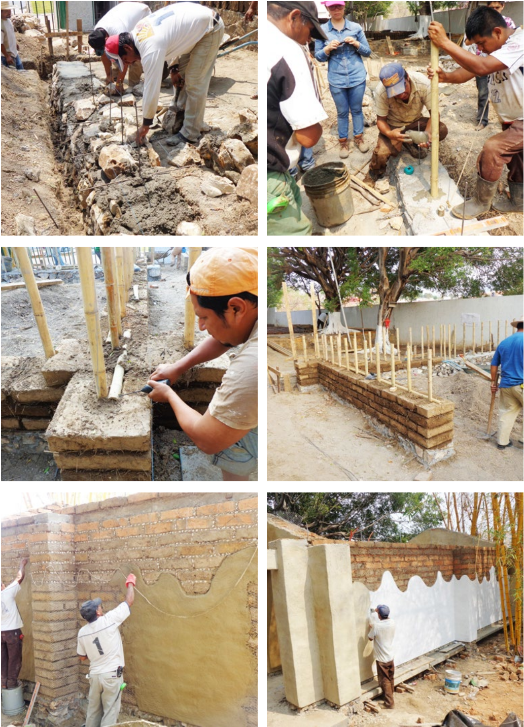
Proceso constructivo del adobe sismo resistente
