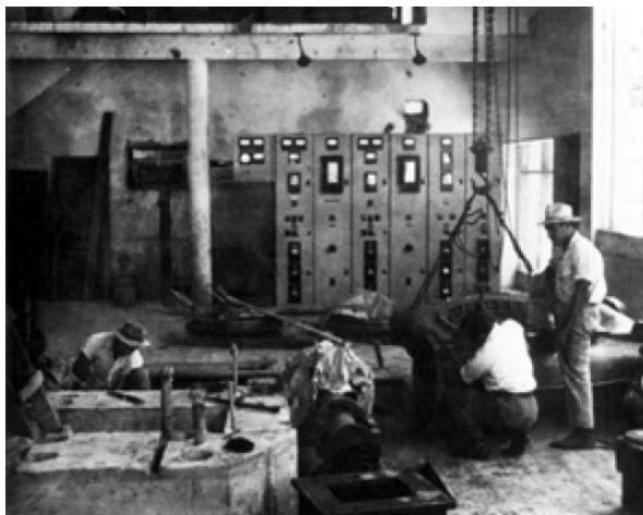
Ilustración 16. Montaje de turbinas, planta hidroeléctrica Carrillos (1950)
