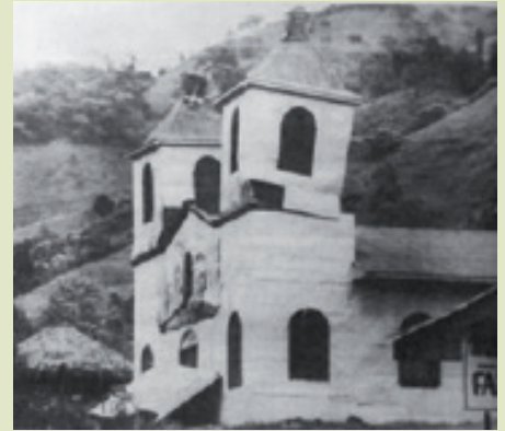
La Iglesia de Buena Vista sufrió severos daños. La Nación, Jueves 07 de julio de 1983.
