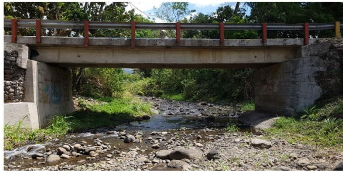
Puente en Quebrada Brava
