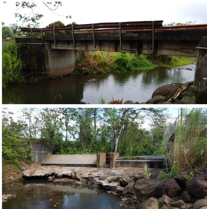
Puente ubicado el Norte del centro del poblado de San Isidro (arriba) y dique en última sección del Río Frijoles (abajo)
