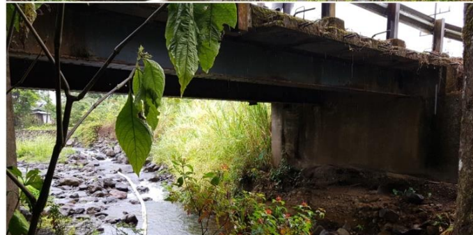
Puente en Quebrada Huacas
