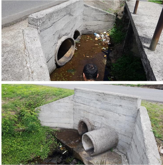
Alcantarilla localizada en el centro del poblado de San Isidro
