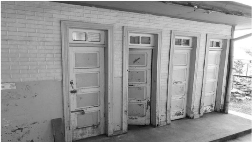
Servicios sanitarios que en la actualidad se siguen utilizando.
