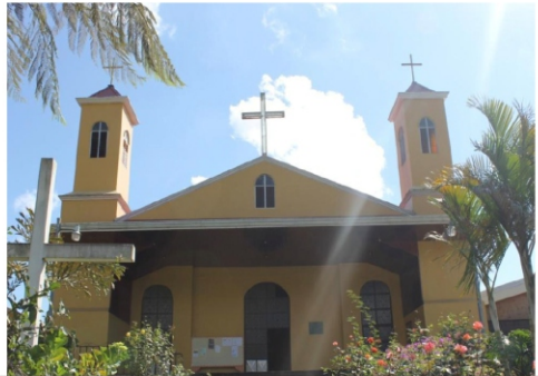
En estas fotografías se pueden apreciar las dos torres como muestra de retomar la estructura original.
