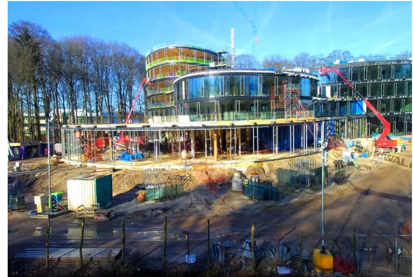
Figura 13 Instalación de cristales. Fuente: RAU Architects.
