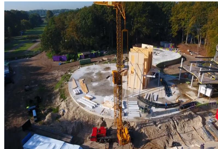
Figura 10 Primeras fases de construcción. Fuente: RAU Architects
