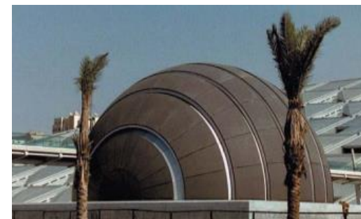
Figura 78 Aplicación del cemento en cubiertas. Fuente: GRC International
