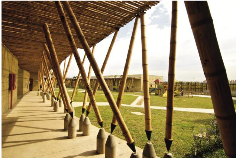
Figura 83 Sistema estructural en guadua. Fuente: Plataforma arquitectura
