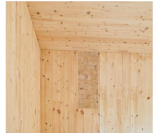
Figura 26 Terminado de madera laminada. Fuente: Plataforma Arquitectura
