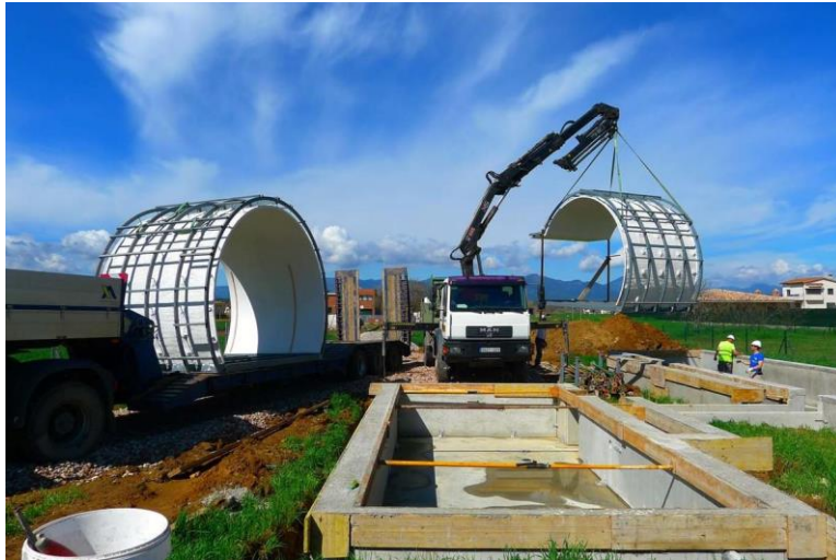
Figura 58 Construcción de vivienda. Fuente: Constucción21.org
