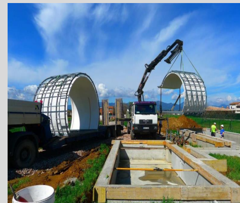
Figura 75 Construcción de vivienda. Fuente: Constucción21.org
