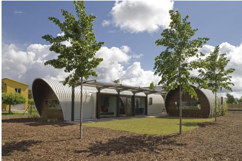
Figura 57 New life style, vista exterior. Fuente: Constucción21.org
