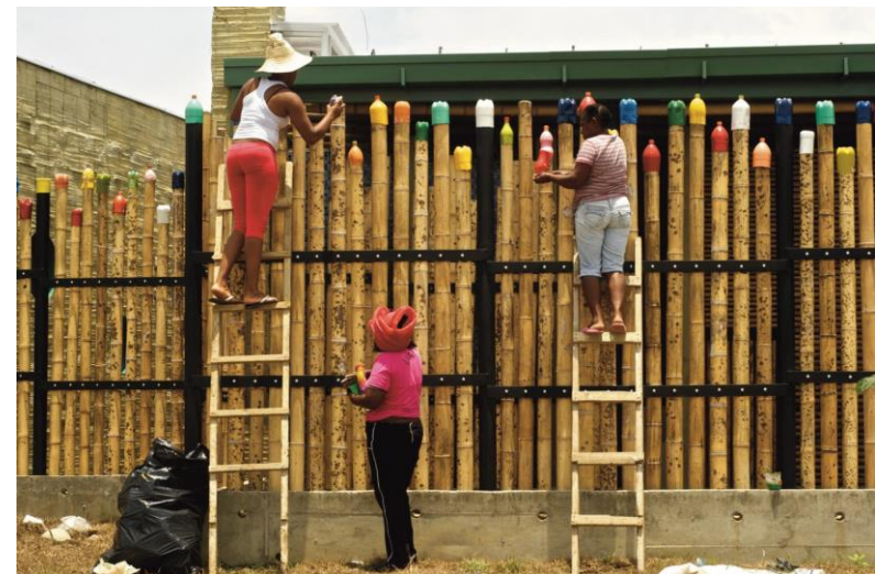
Figura 87 Valla perimetral. Fuente: Plataforma arquitectura
