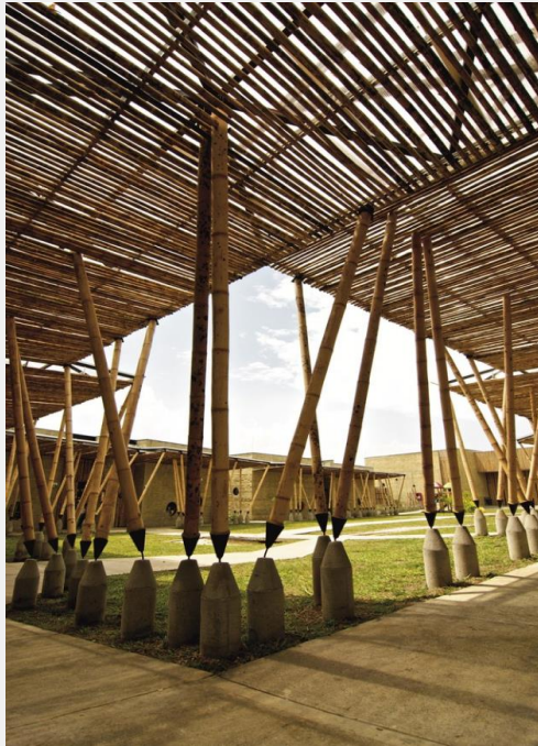
Figura 100 Estructura interior. Fuente: Plataforma arquitectura
