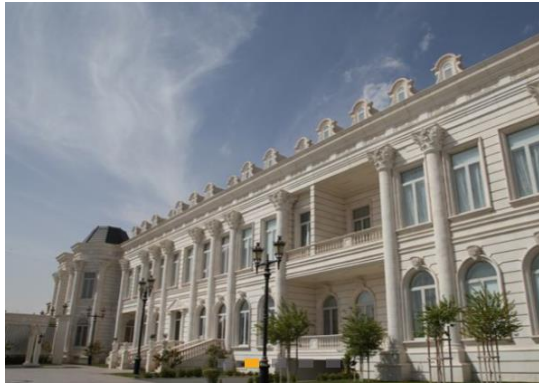
Figura 79 Al Asmakh Palace Fuente: GRC International
