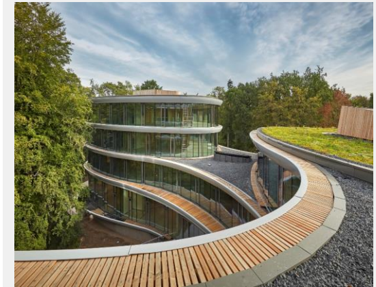
Figura 24 Terrazas. Fuente: RAU Architects
