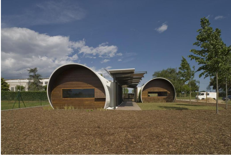
Figura 61 Vista módulo de vivienda. Fuente: Constucción21.org
