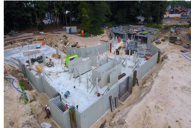
Figura 9 Sótano. Fuente: RAU Architects
