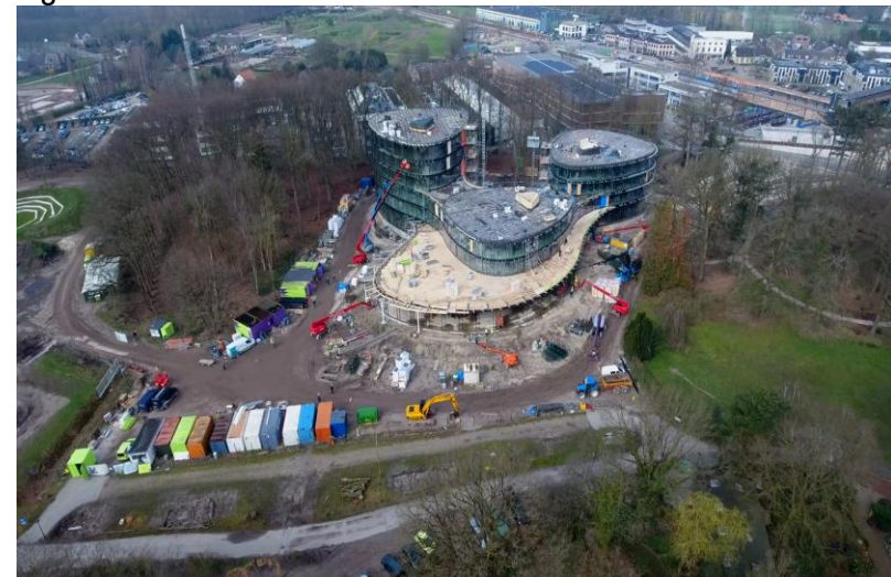
Figura 14 Proceso al 70% de obra gris. Fuente: RAU Architects.
