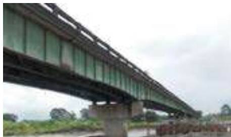
Fig. 1. Vista Lateral del puente sobre el río Chirripó.
