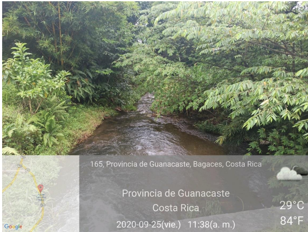
Figura 9-20 Alcantarilla en cauce de Quebrada Hornillas.
