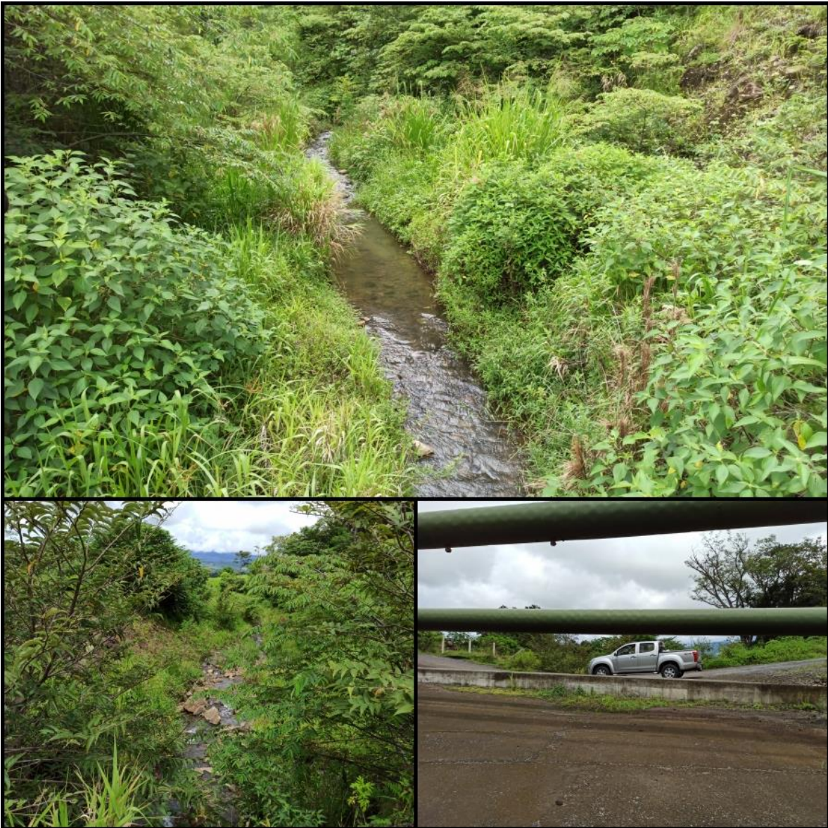
Figura 9-18 Alcantarilla ubicada en zona alta antes de Termomanía.
