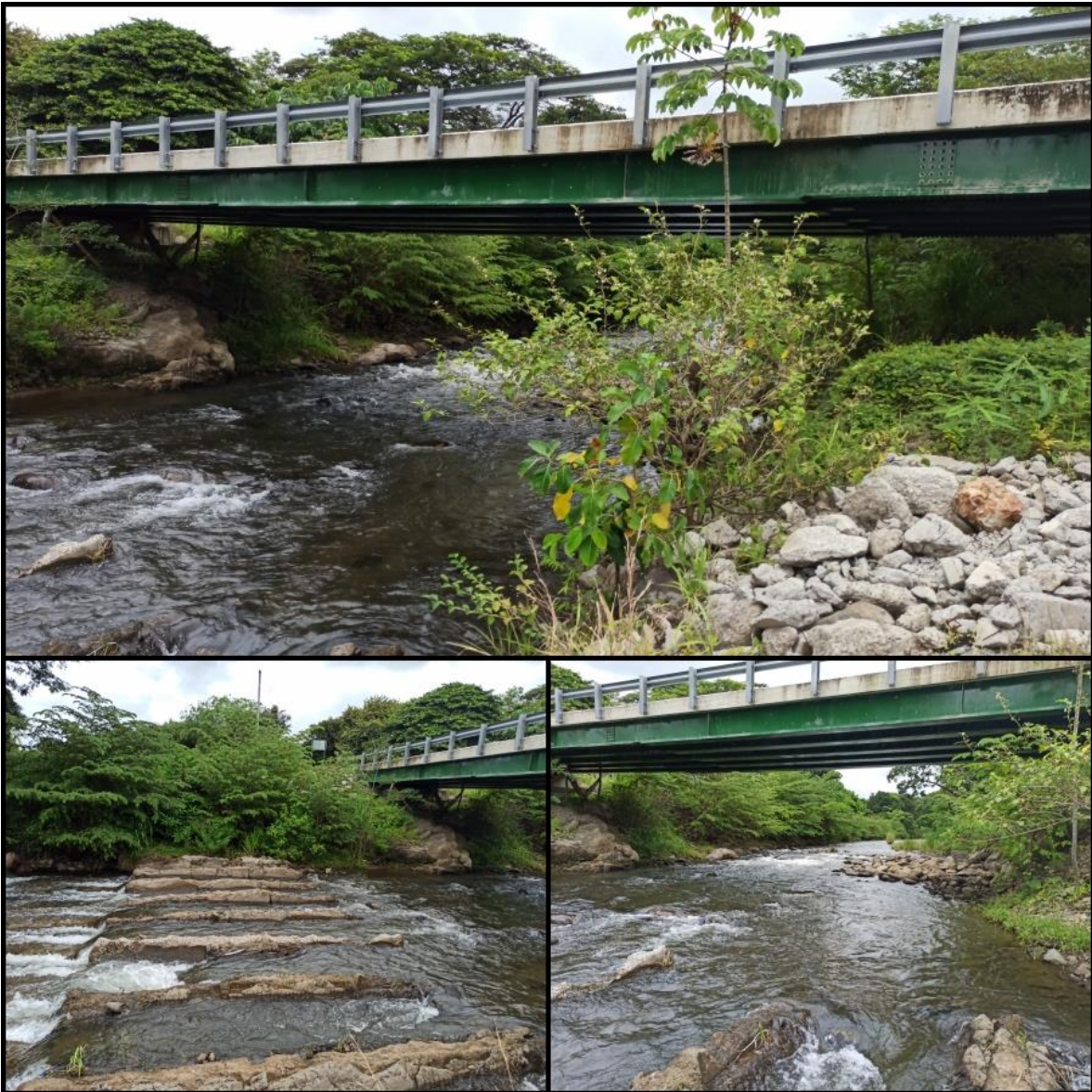
Figura 9-11. Puente en la parte baja del modelo de Cuipilapa, fotos tomadas aguas abajo del puente.
