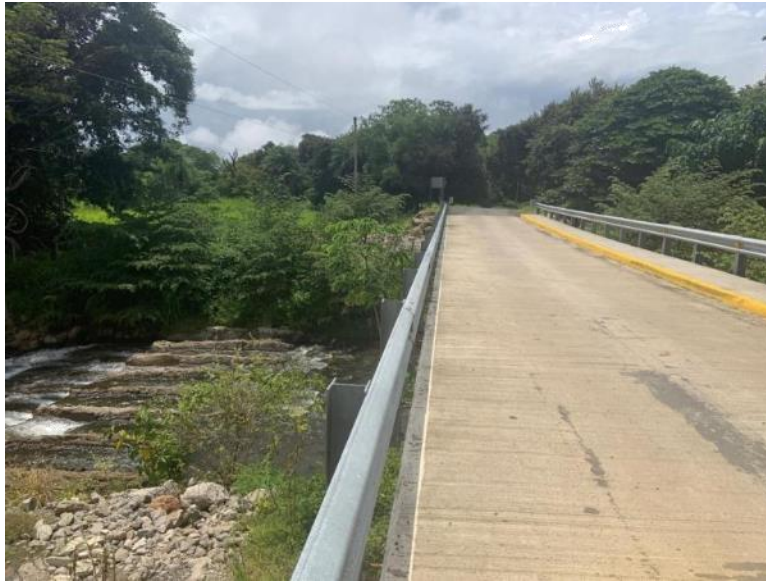
Figura 9-12 Superficie de rodaje del puente en la zona baja de Cuipilapa
