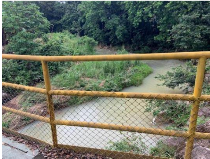
Figura 9-9 Puente ubicado sobre la Q. Hornillas a las residencias del ICE
