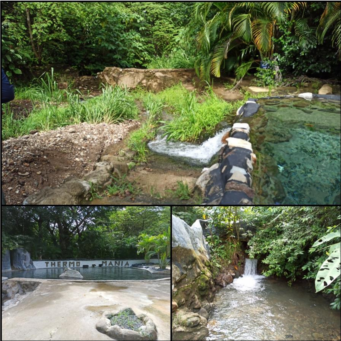
Figura 9-16 Vertedero a la salida del centro turístico Thermomanía y estructura en cauce.
