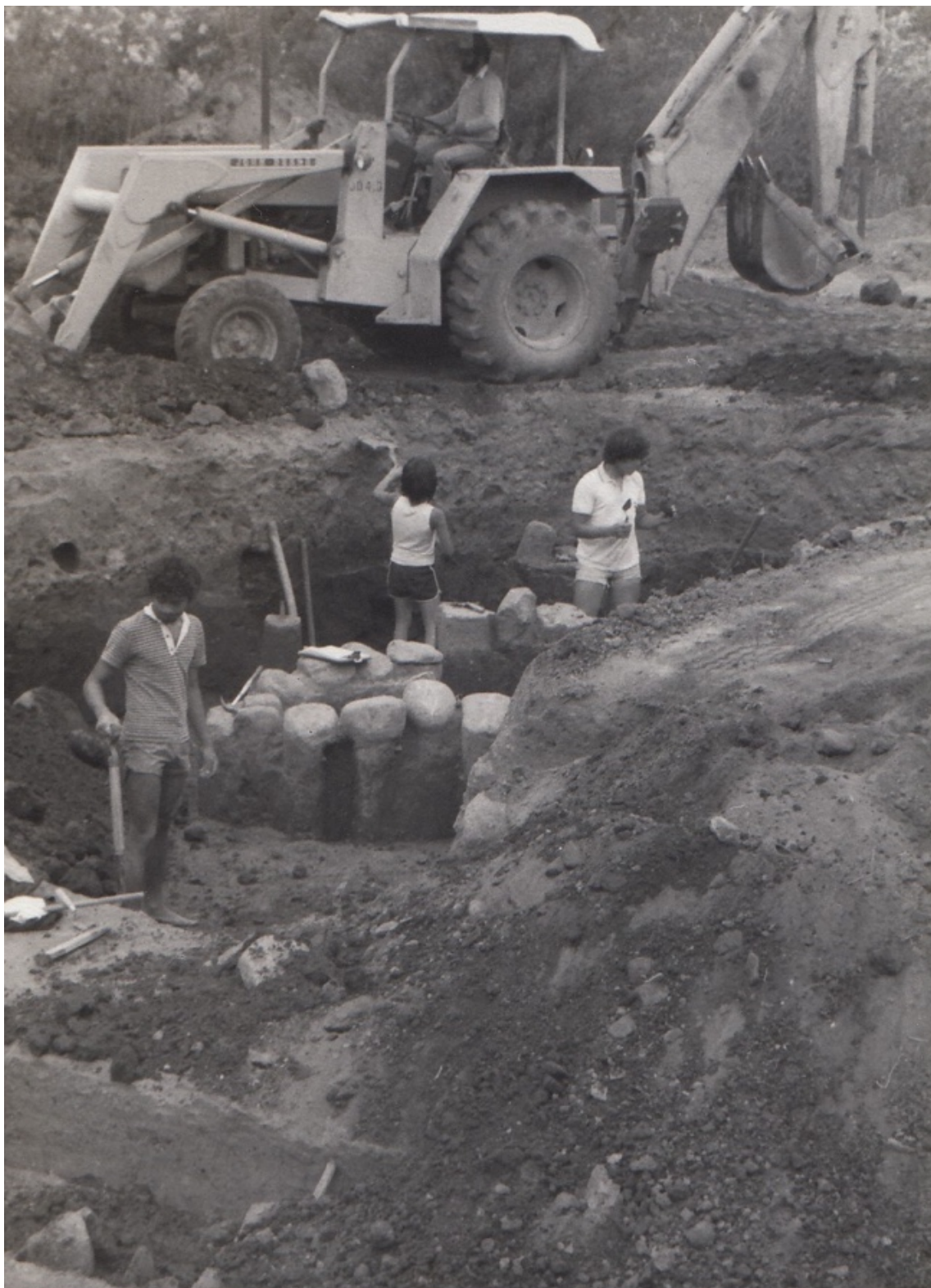
Figura 12 Excavación en La Pesa Vieja
