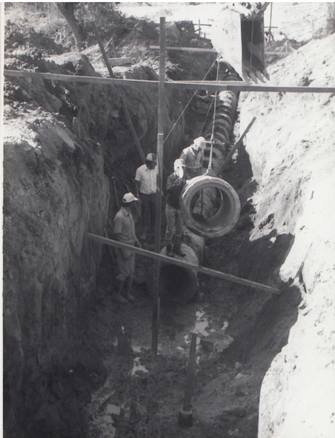
Figura 13 Trabajo del INVU en La Pesa Vieja Colocación de sistema de alcantarillado por el proyecto del INVU. Fuente: Fotografía de Snarskis (1985) propiedad del LACAP.
