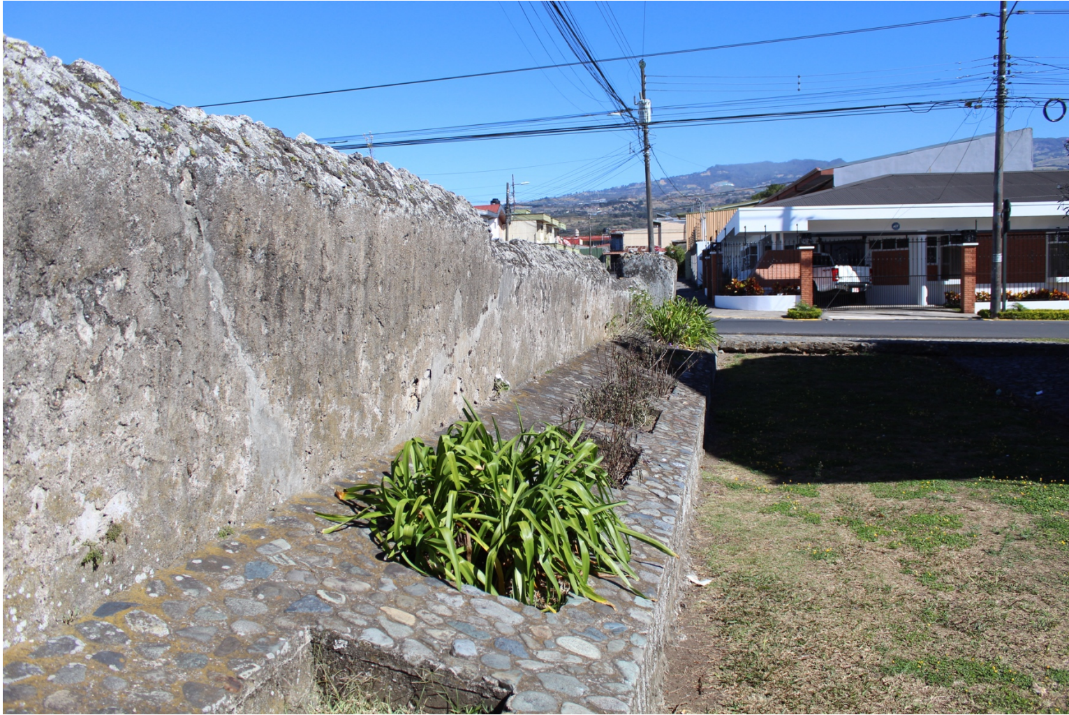
Figura 6 Muros antiguos La Pesa Vieja
