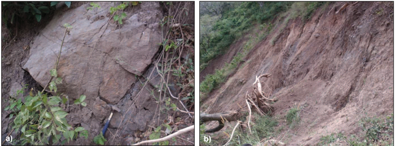
Figura 40. a) Bloques con planos de falla b) Posible zona de falla cubierta por coluvio.
