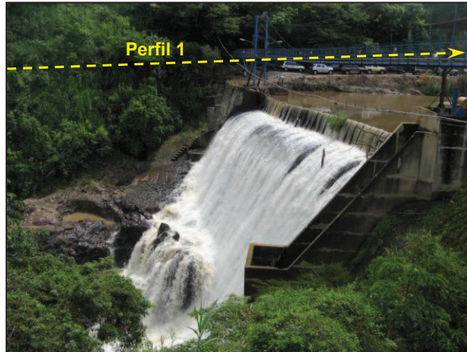
Figura 49. Perfil 1, margen derecha en sitio de Presa Electriona.
