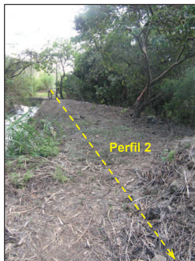
Figura 50. Perfil 2, margen izquierda del sitio de presa Electriona.
