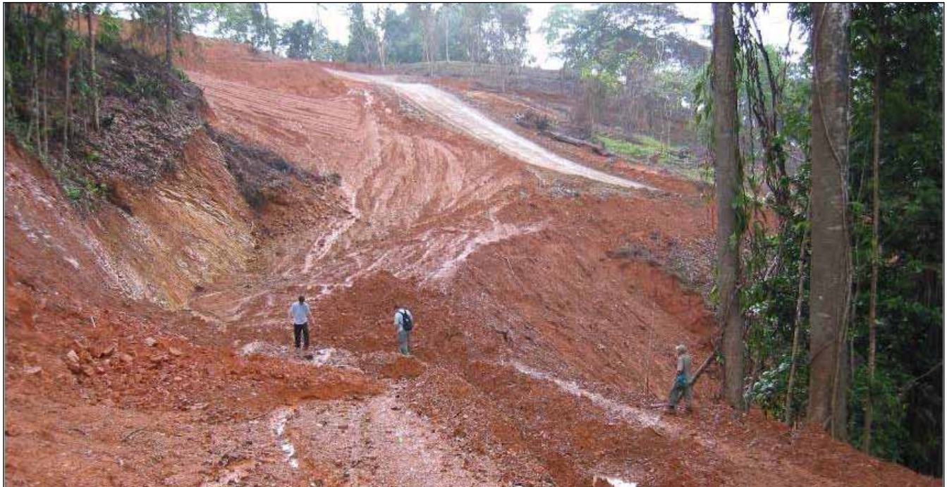
Aspecto de una urbanización en desarrollo durante la fase de construcción, durante la época lluviosa. Urbanización Las Brisas, empresa Punta Ibérica, 2,6 km al NE de Playa Piñuela, cuenca de la quebrada Piñuela. Se aprecia el intenso movimiento de suelo provocado por el escurrimiento del agua en la superficie del suelo, y el comienzo del desarrollo de grietas profundas de erosión (cárcavas). Foto de Jorge Lobo.
