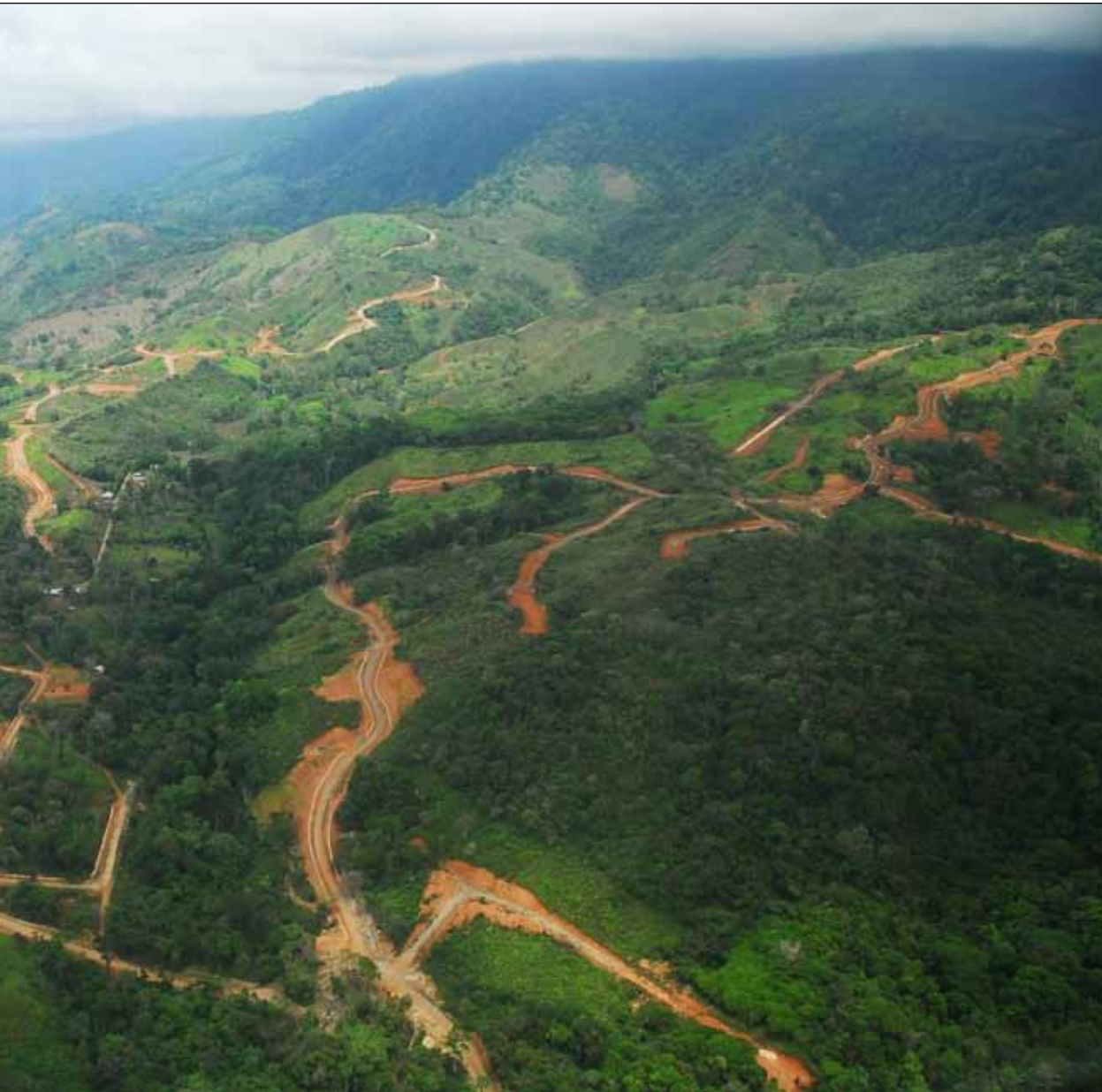
Vista aérea de la construcción de una urbanización turística al norte de Playa Tortuga, en la Fila Costeña. Foto de CAVU.
