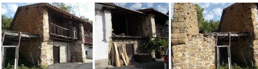
Figura 14. Edificaciones abandonadas o en estado ruinoso en Correpoco.
