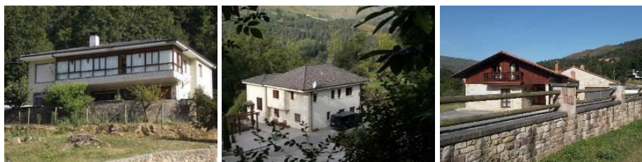
Figura 13. Nuevas edificaciones junto a la carretera en Correpoco.
