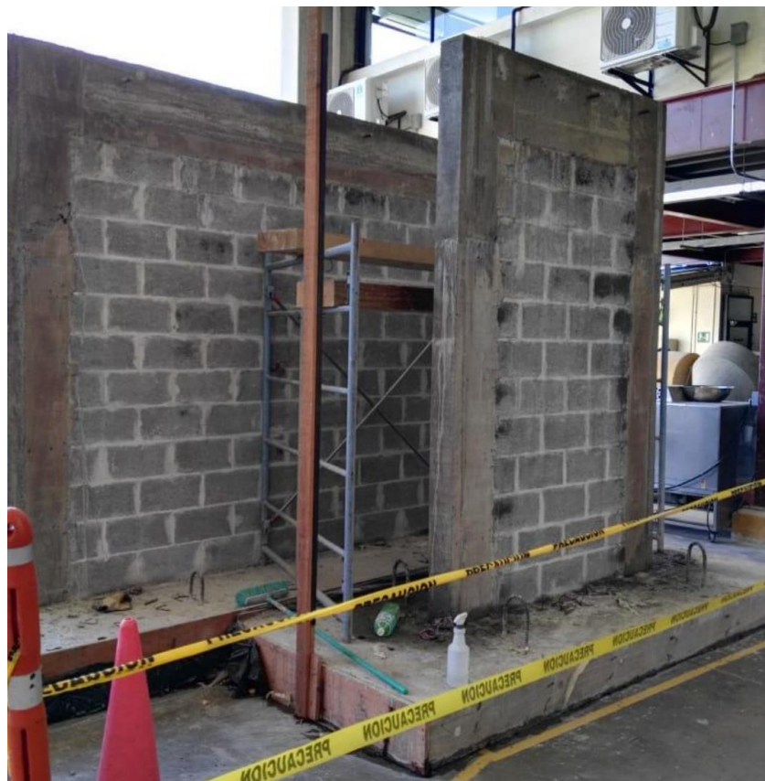
Figura 1-26. Muros finalizados y en proceso de curado
