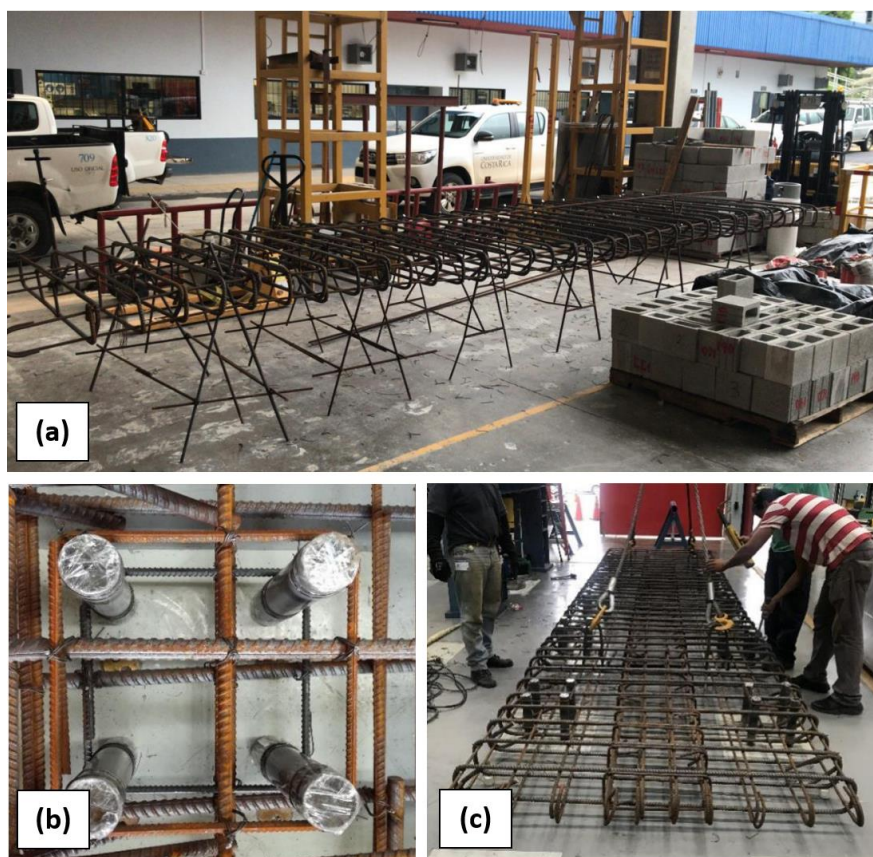
Figura 1-22. (a) Armadura de cimentación (b) Ductos para pernos de anclaje (c) Ajustes en piso fuerte
