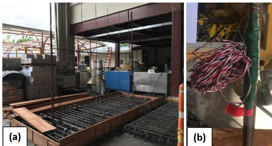
Figura 1-23. (a) Armadura encofrada (b) Galgas extensométricas con protección
