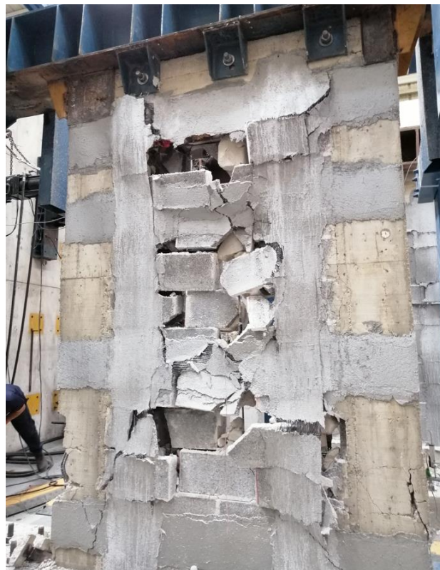
Figura F-30. Muro N' después de la falla.
