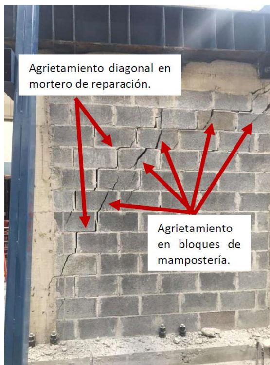
Figura F-28. Muro M' después de la falla.
