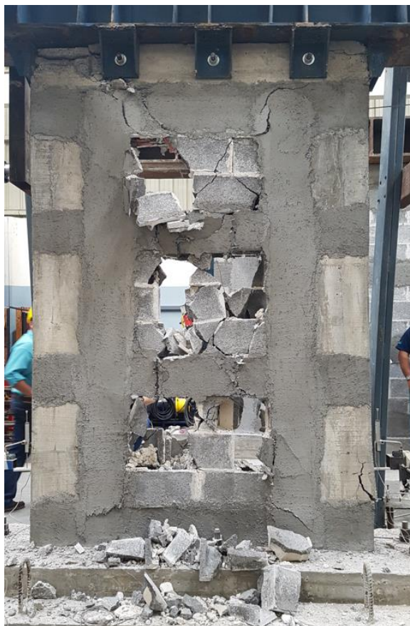
Figura F-23. Muro I' después de la falla.
