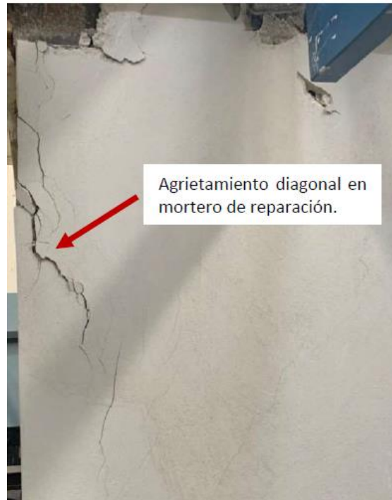
Figura F-25. Muro K' después de la falla.
