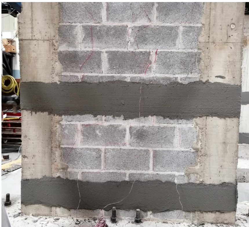
Figura F-15. Muro N después de la carga e iniciado el proceso de reparación con sistema de reforzamiento FRCM
