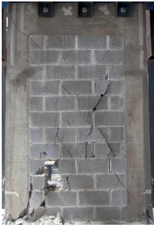
Figura F-4. Muro D después de la falla.
