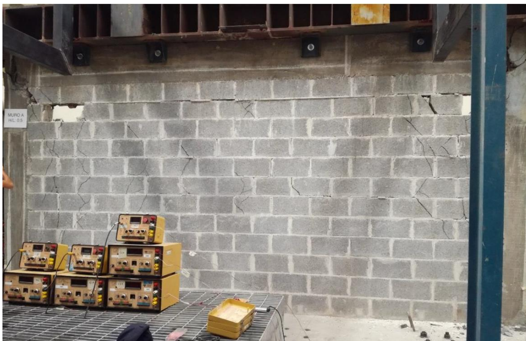
Figura F-1. Muro A después de la falla.
