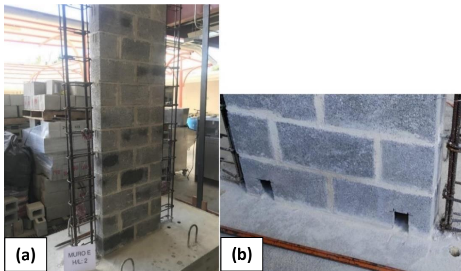
Figura 1-24. (a) Paño de mampostería terminado (b) Ventanas de inspección en hilada inferior
