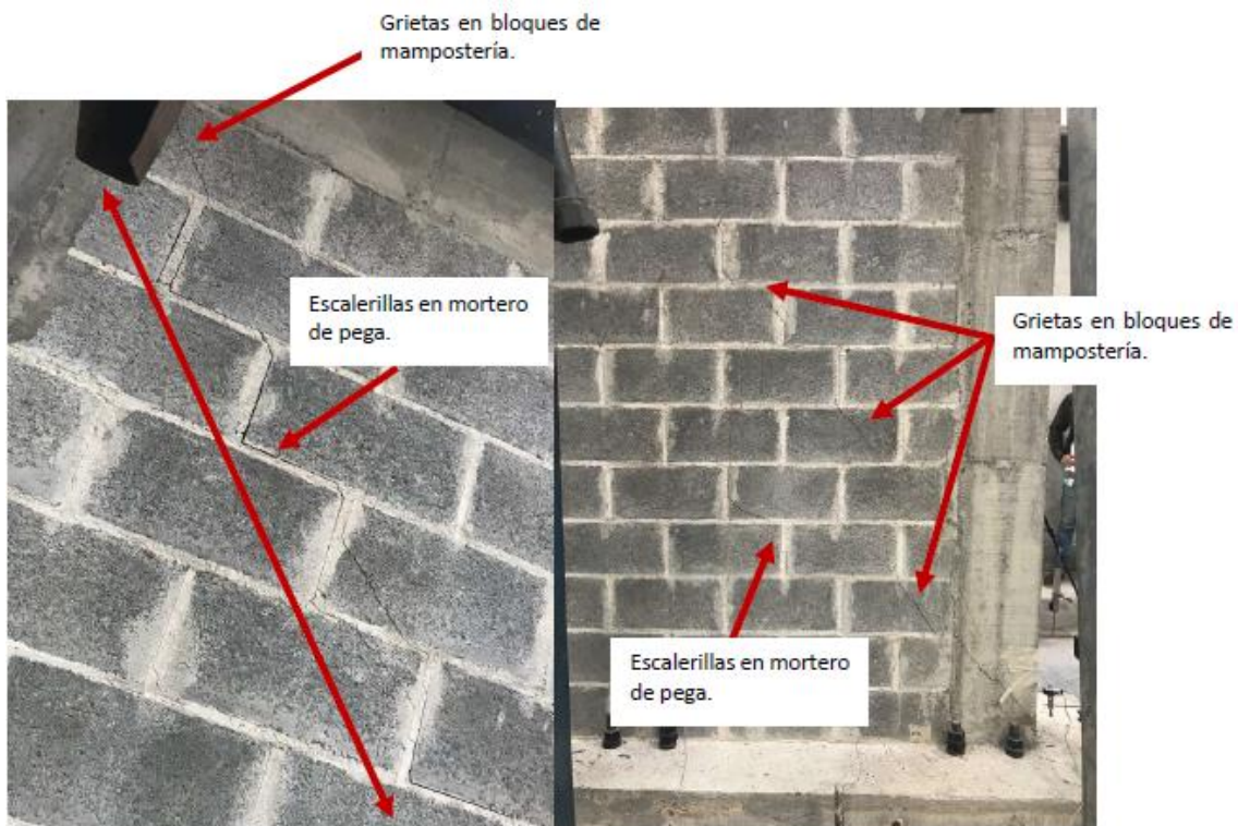
Figura F-21. Muro H' después de la falla.
