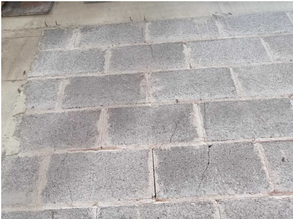
Figura F-12. Parte del paño del muro L después de la carga.
