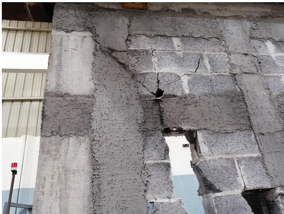
Figura F-19. Parte del muro G' después de la carga.
