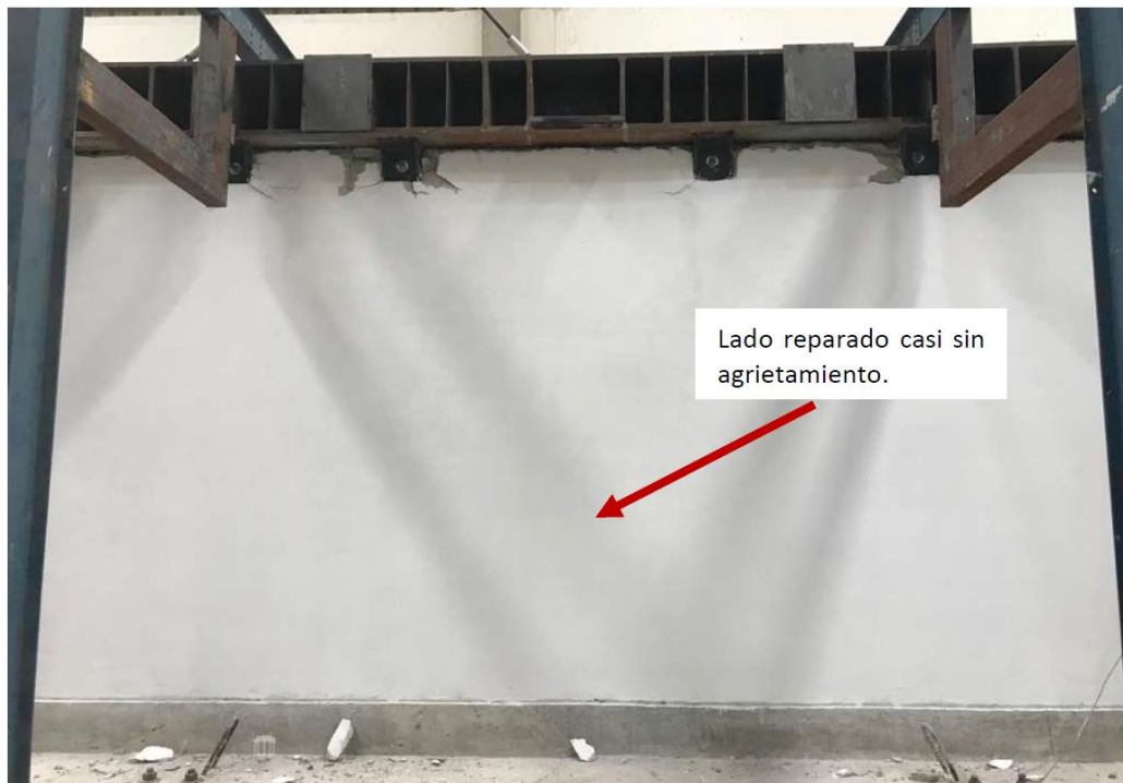
Figura F-17. Muro F' después de la falla.
