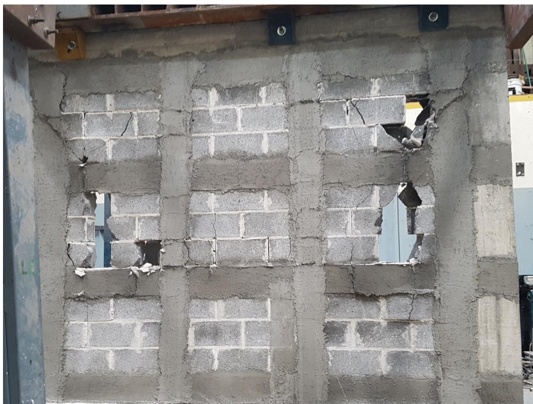
Figura F-20. Muro G' después de la carga.
