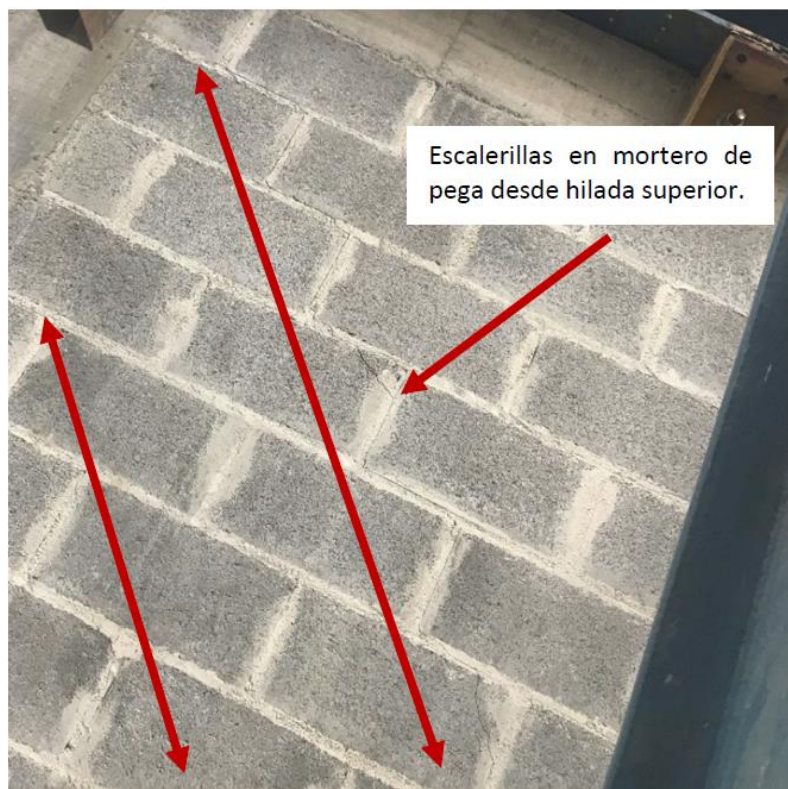
Figura F-7. Parte del paño del muro H después de la carga.
