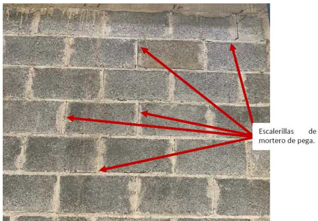
Figura F-14. Parte del paño del Muro M después de la carga.
