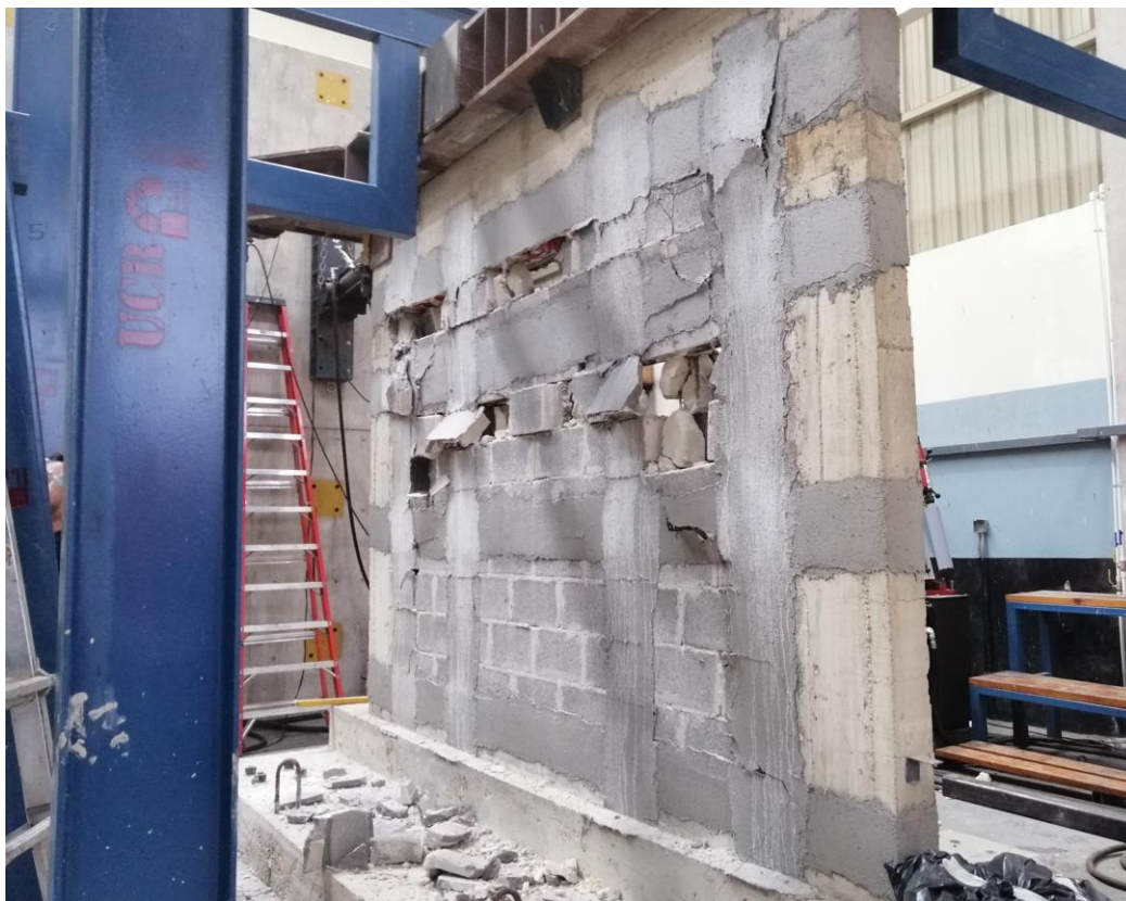
Figura F-27. Muro L' después de la falla.
