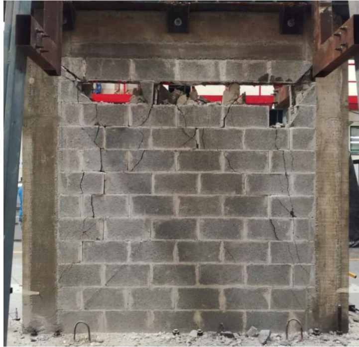
Figura F-3. Muro C después de la falla.
