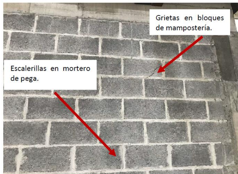
Figura F-6. Parte del paño del muro F después de la carga.
