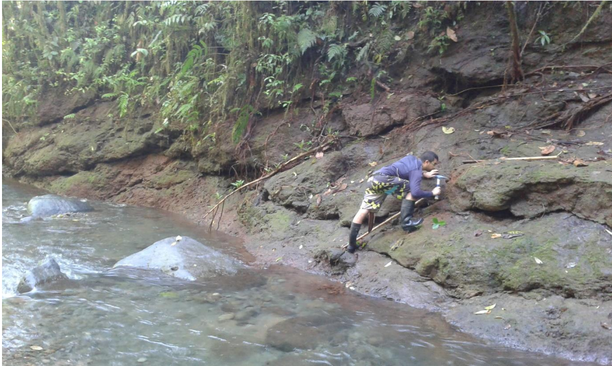
Figura 13. Brecha meteorizada con diaclasamiento expansivo en las márgenes del río San Lorencito, en la foto se aprecia como la erosión fluvial ha socavado secciones proximales al cauce. (Solano-Rivera & Granados-Bolaños, 2017).
