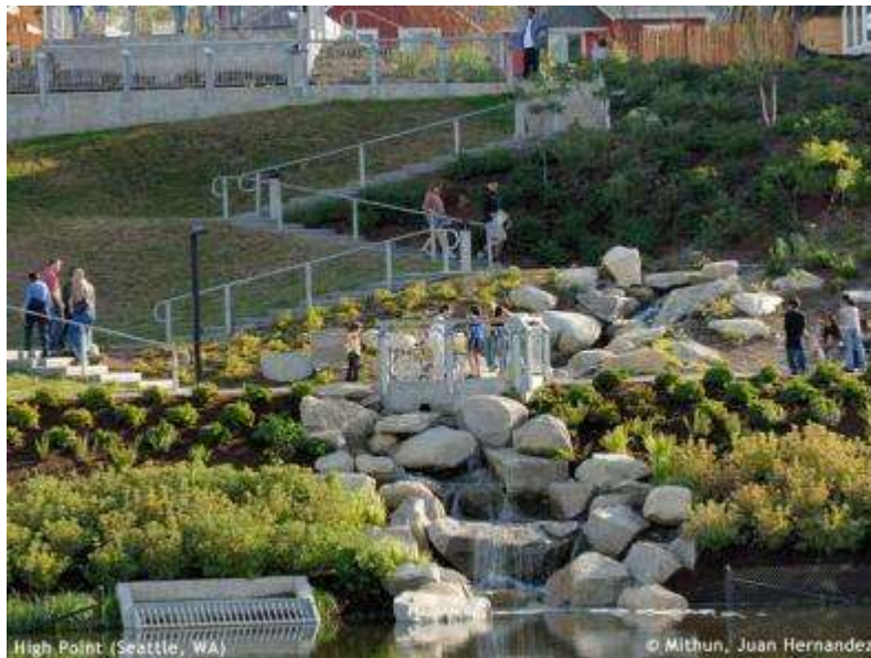
Fotografía no.1 Desagües y drenajes High Point
