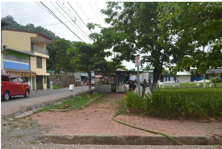
Fotografía no.32 Parque área civil, quiosco obstaculizando el paso
