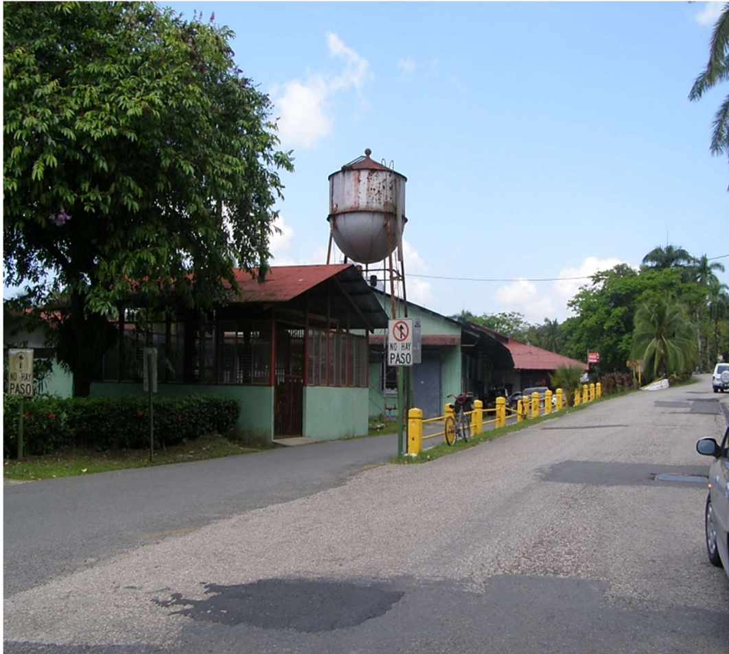
Fotografía no. 39 Tanque de Agua cerca barrio Alamedas
