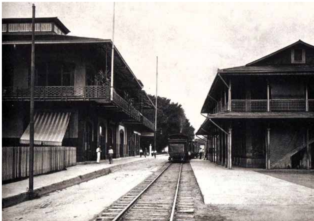
Calle de Puerto Limón, 1922 (Foto Manuel Gómez Miralles)
