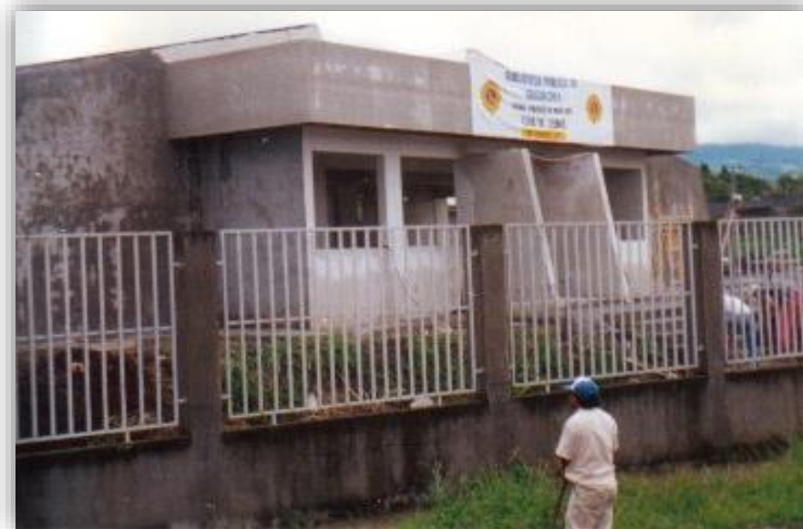
Figura 3. Inicio de la construcción de la Biblioteca Pública de Goicoechea en 2000. Tomado del archivo institucional de la Biblioteca Pública de Goicoechea.
