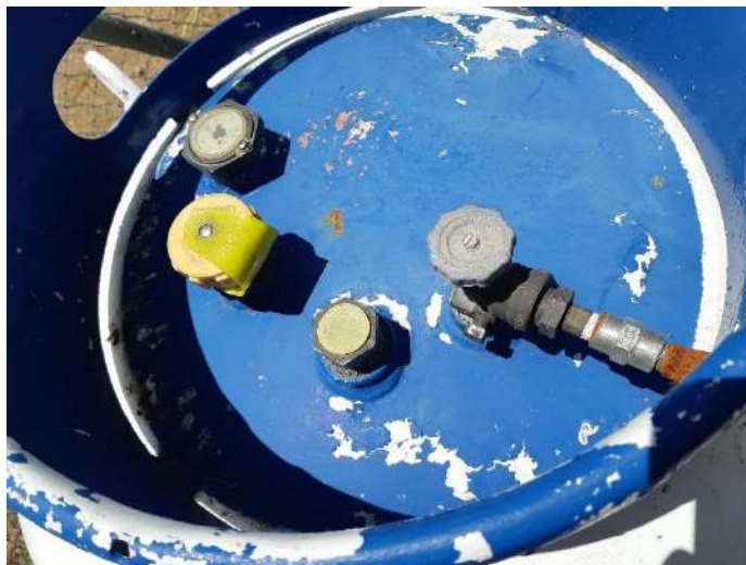
Figura 49. Arriba, vista panorámica del tanque de GLP Facultad de Ciencias Sociales y abajo, vista superior de sus válvulas.
