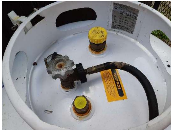
Figura 45. Arriba, vista panorámica del tanque de GLP Facultad de Farmacia y abajo, vista superior de sus válvulas.
