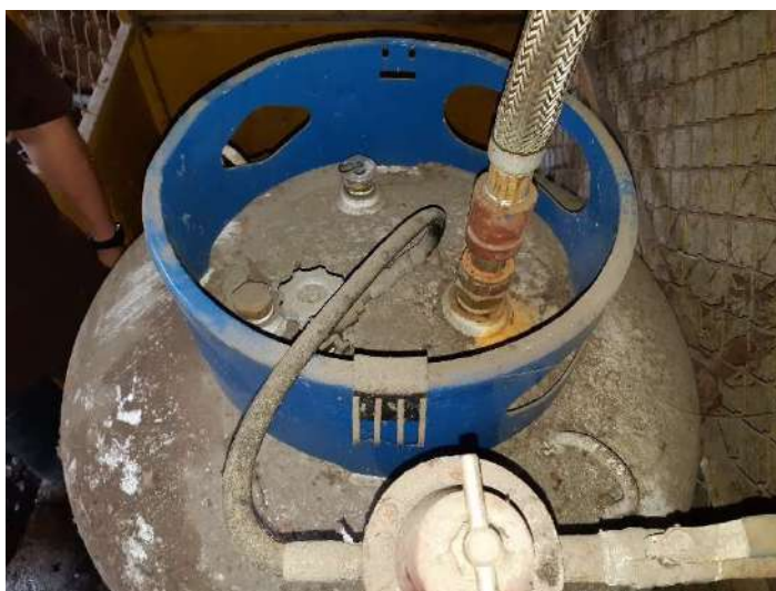
Figura 37. Arriba, vista panorámica del tanque de GLP Escuela de Química y abajo, vista superior de sus válvulas.
