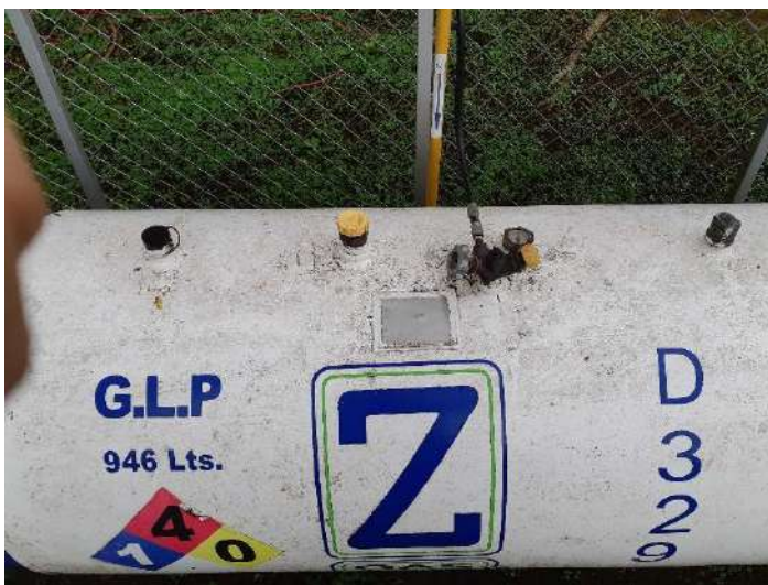
Figura 53. Arriba, vista panorámica del tanque de GLP de CIPRONA y abajo, vista superior de sus válvulas.
