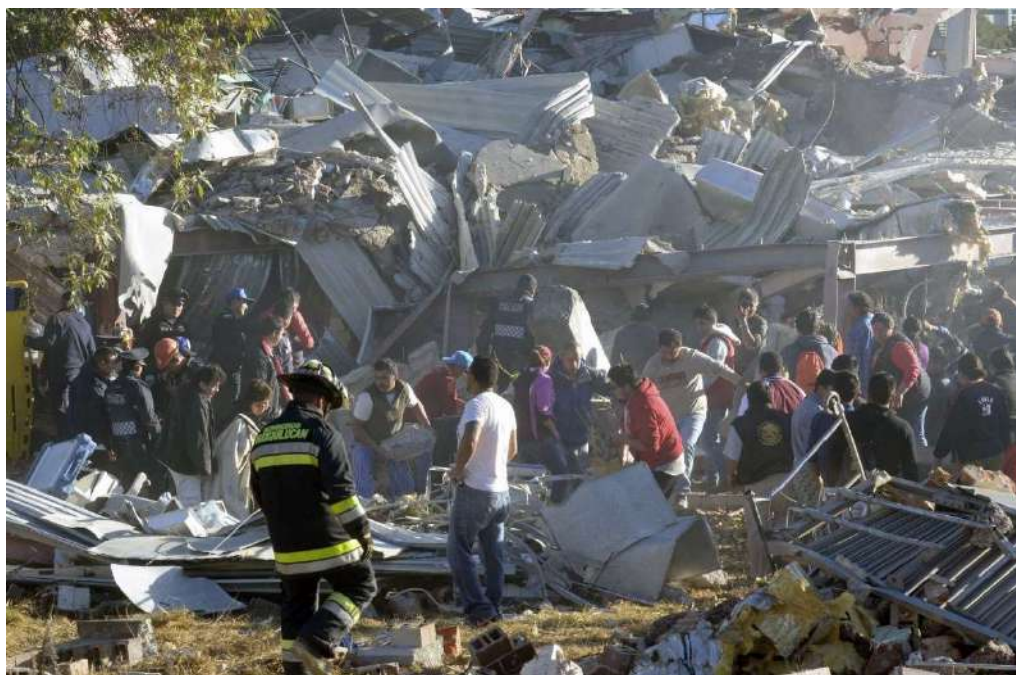
Figura 2. Daños en Hospital Materno Infantil de Cuajimalpa.
