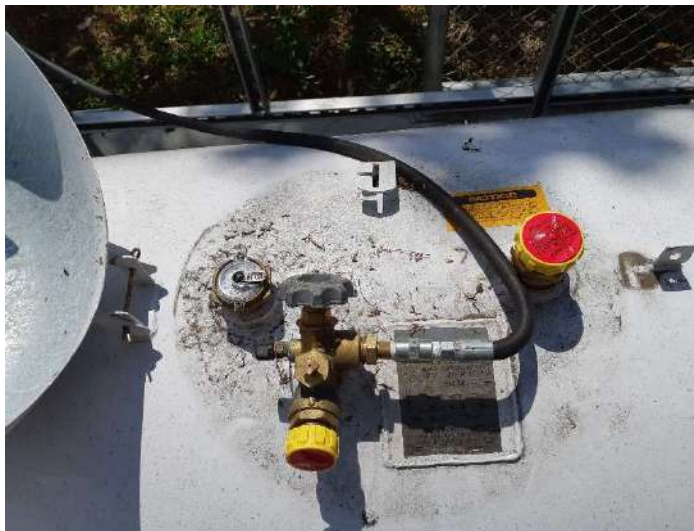
Figura 57. Arriba, vista panorámica del tanque de GLP Facultad de Derecho y abajo, vista superior de sus válvulas
