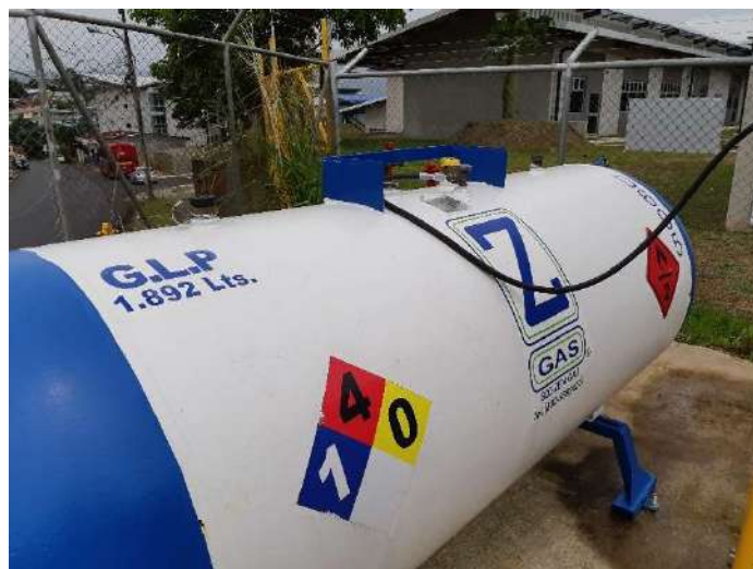
Figura 65. Arriba vista panorámica del tanque de GLP Facultad de Ingeniería y abajo vista superior de sus válvulas.
