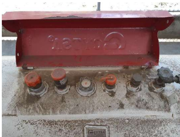
Figura 61. Arriba, vista panorámica del tanque de GLP Facultad de las Residencias Estudiantiles y abajo, vista superior de sus válvulas.
