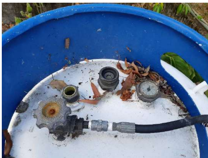
Figura 41. Arriba, vista panorámica del tanque de GLP Facultad de Microbiología y abajo, vista superior de sus válvulas.
