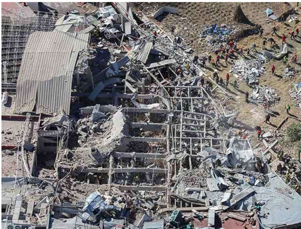
Figura 3. Daños en Hospital Materno Infantil de Cuajimalpa.
