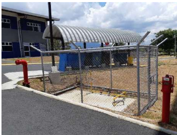
Figura 33. Área designada para instalar tanque de GLP para la Soda de la Facultad de Ingeniería.
