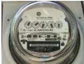
Contador de electricidad 90.28
