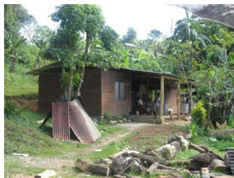
Fotografía 23. Vivienda con electricidad en Abrojo Montezuma, 31 de enero de 2008.
