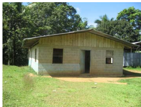
Fotografía 15. Instalaciones de la Telesecundaria en Abrojo, Abrojo Montezuma, 9 de julio de 2009 Fuente: ProDUS. Trabajo de campo.
