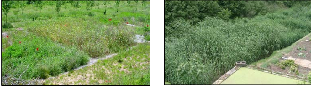
Figura 8-6.8. Perspectiva de humedales de flujo subsuperficial horizontales para tratamiento de aguas residuales de pequeñas poblaciones.
