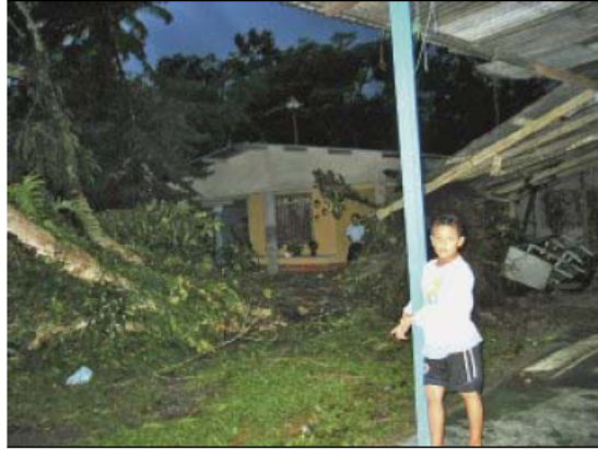
La caída de árboles causó daños en viviendas y dejó sin fluido eléctrico a varios sectores. Freddy PARRALES para LN
