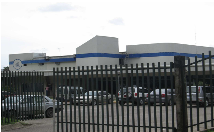
Fotografía 8-2.1 Vista del Hospital de Neily
