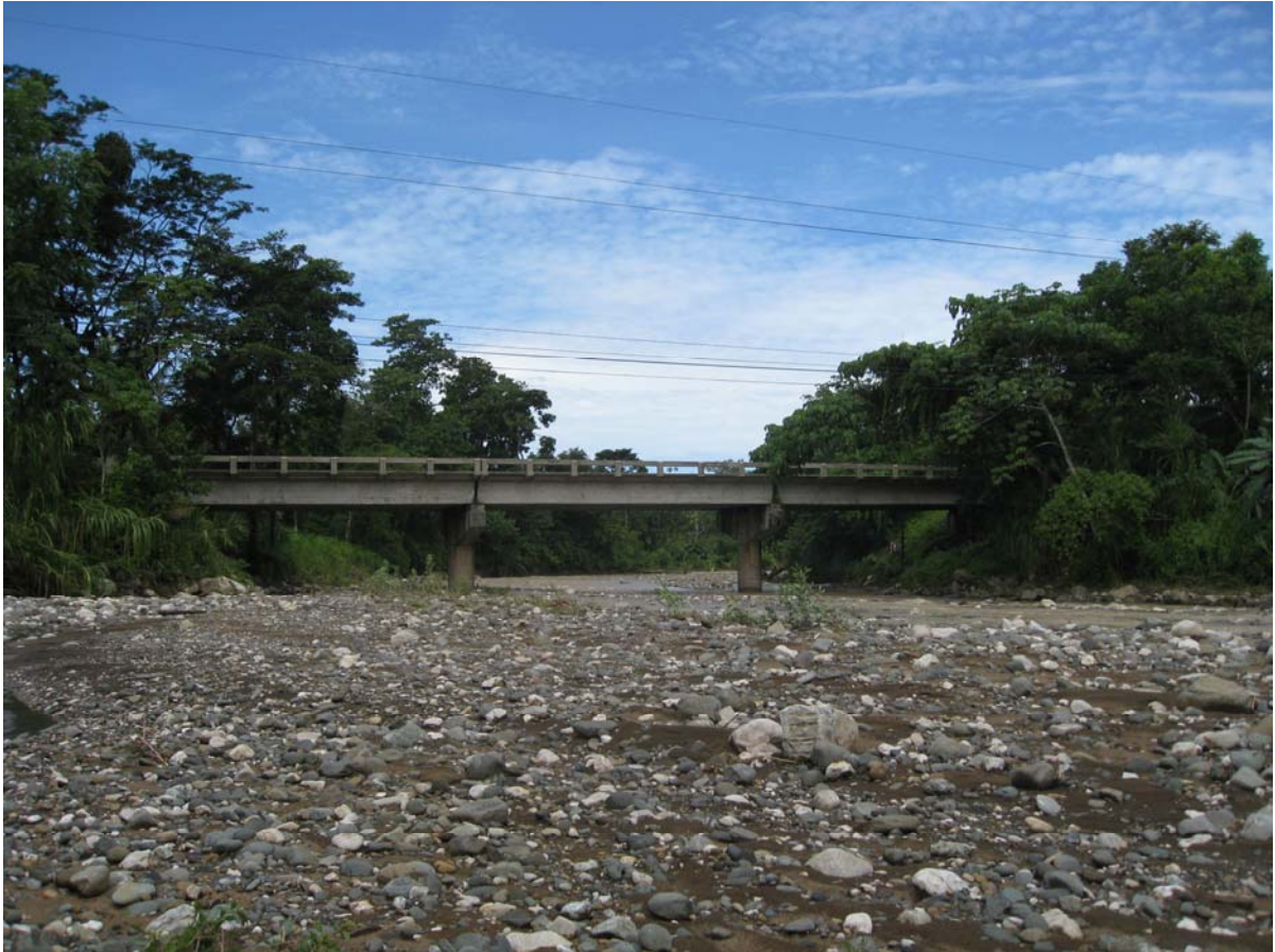
Fotografía 8: Puente sobre el río Caracol.
