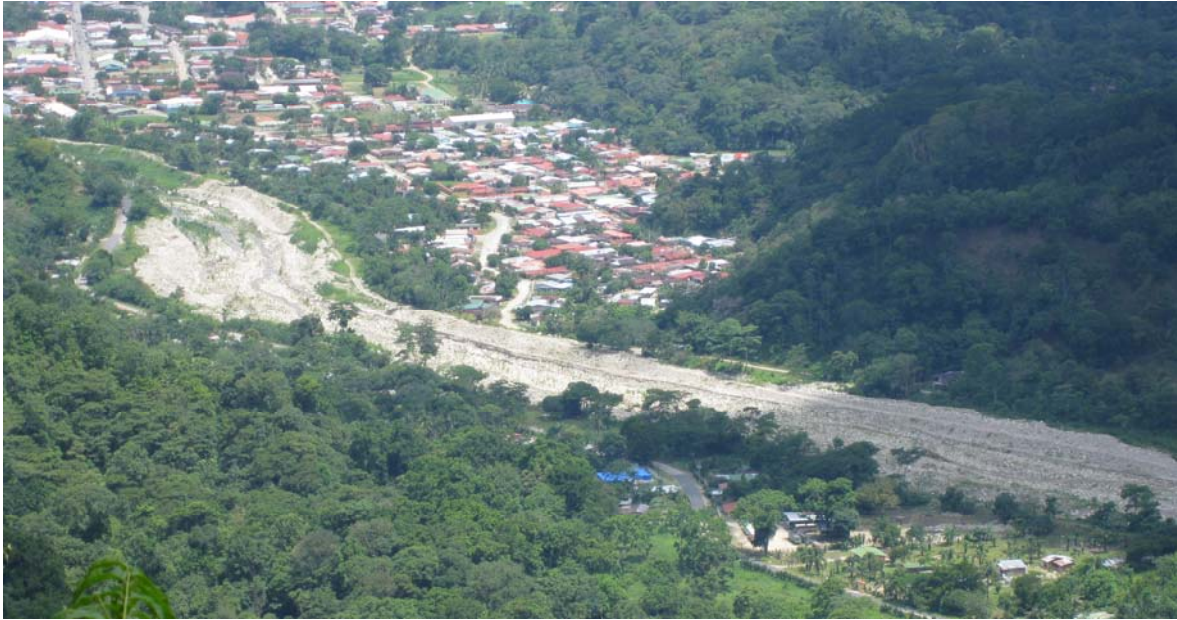
Fotografía 8: Detalle de los diques aguas arriba de Ciudad Nelly.
