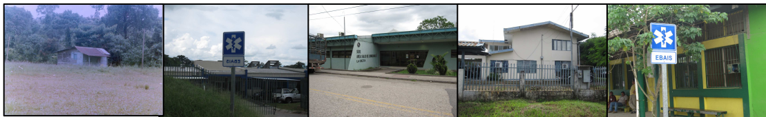
Fotografía 8-2.2. Vista de diferentes EBAIS en Corredores
