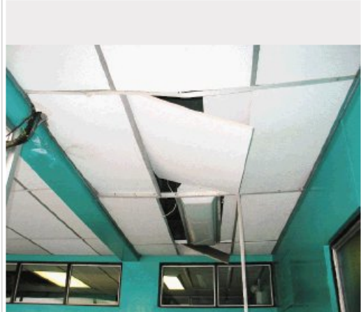
El cielorraso en un corredor a la entrada de la sala de cirugías del hospital de Ciudad Neily se desprendió. Freddy Parrales para LN
