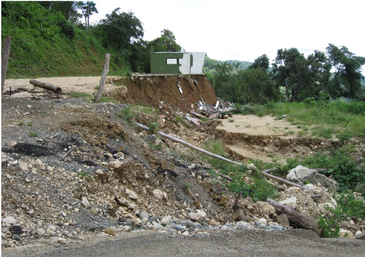
Fotografía 3: Deslizamiento en la ruta nacional 273. Fuente: ProDUS, trabajo de campo.
