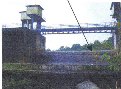
Foto B5: Represa de la toma de agua del ICE, zona de captación de agua, gracias a las grillas en la parte arriba. A este nivel se puede controlar el caudal a extraer.
