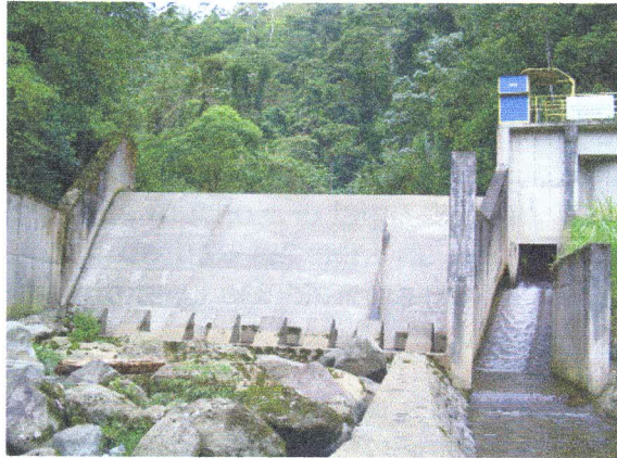
Foto B7: Represa privada en el Río Tuís
