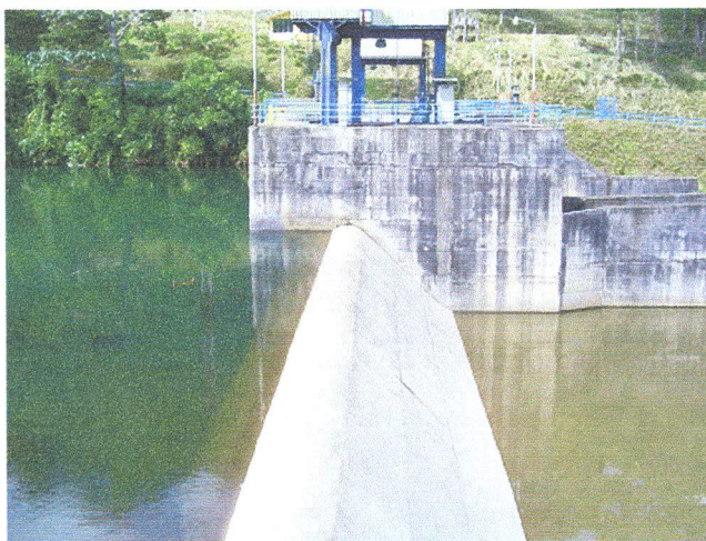
Foto A6 : Represa de la toma de agua en La Suiza
